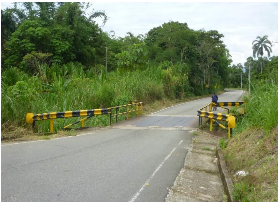
Figura 14 Estado actual del puente Km. 6+700.
