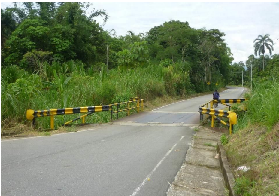
Figura 5. Foto - Vista general del área de influencia del Puente Sindy Dos
