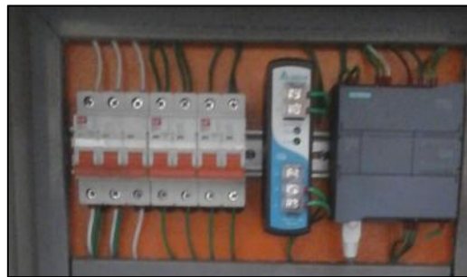
Figura 142. Disyuntores, de izquierda a derecha: tripolar, bipolares
