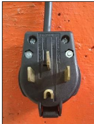
Figura 134. Conector trifásico
