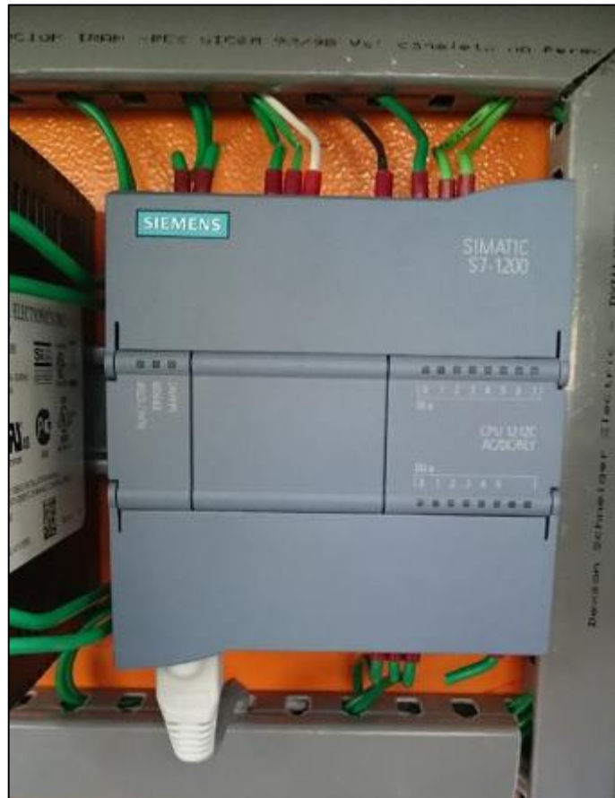
Figura 150. PLC instalado
