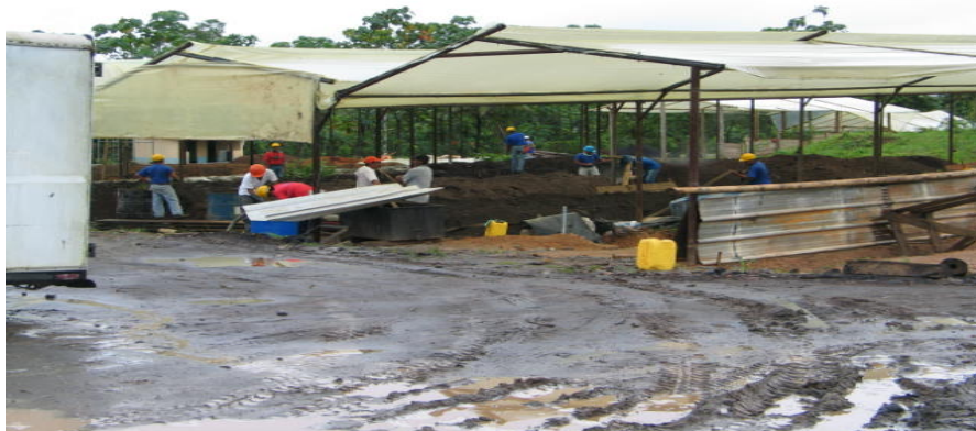
Figura 106 Tratamiento de material contaminado con hidrocarburos
