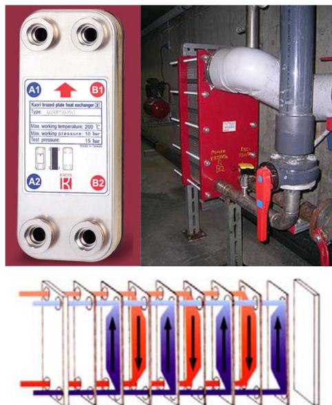
Figura 7. Intercambiador de calor de placas
