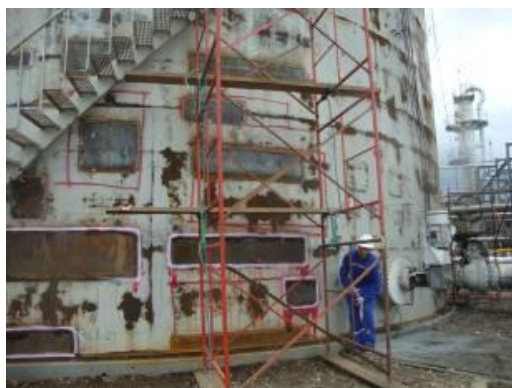
Fotografía 13. Inspección PT en parches instalados.
