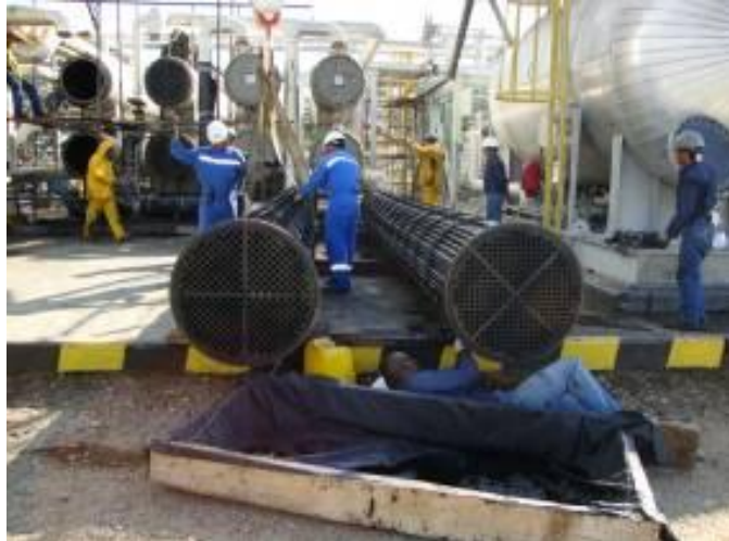
Figura 39 Inspección visual intercambiador de calor
