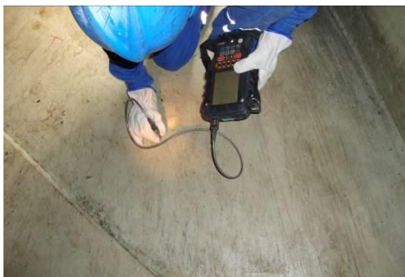
Figura 23 Inspección interna acumulador V-3012
