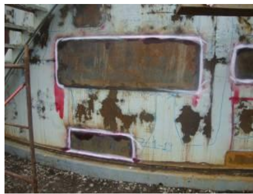
Fotografía 14. Inspección PT en parches instalados.
