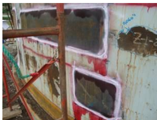
Figura 26 Aplicación ensayo tintas penetrantes
