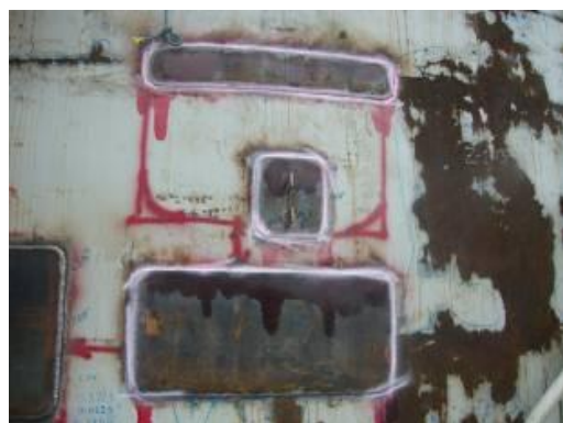
Fotografía 15. Inspección PT en parches instalados.
