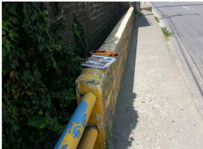
Figura 10 Muro del Puente San Pedro
