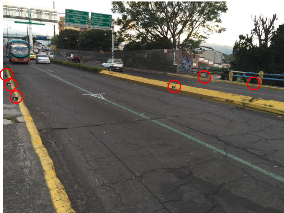
Figura 73 Ubicación de sensores Tramo 1
