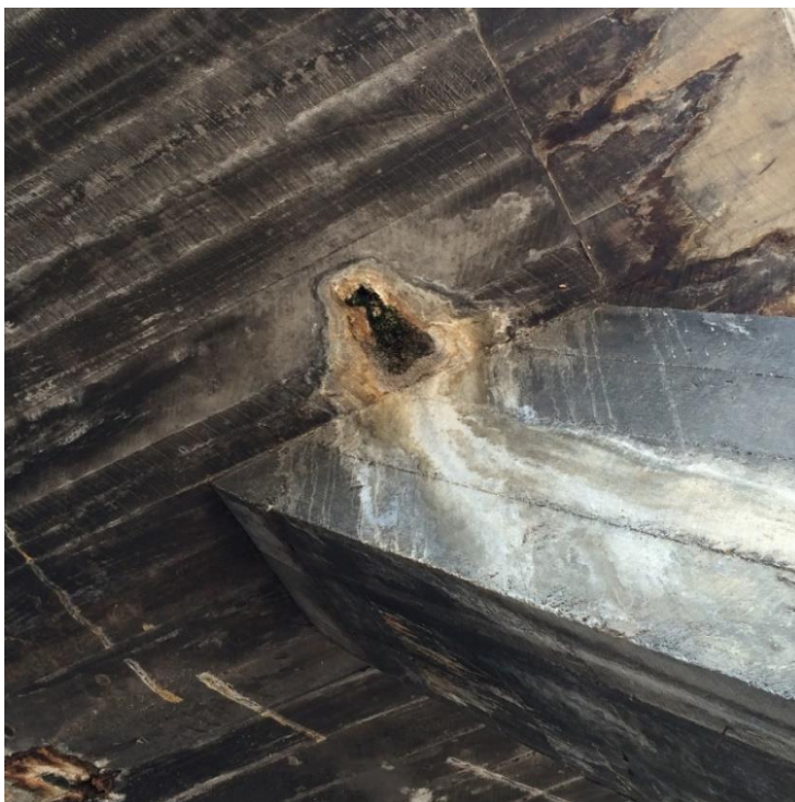
Figura 36 Oquedad en el borde inferior de la Losa
