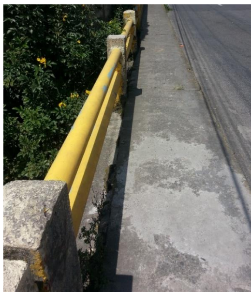
Figura 8 Protecciones del Puente San Pedro
