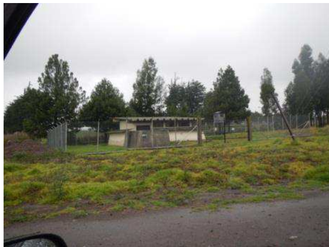
Figura 37 Bodega de munición y explosivos
