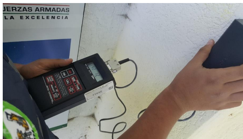
Figura 93 Medición de recubrimiento en columnas
