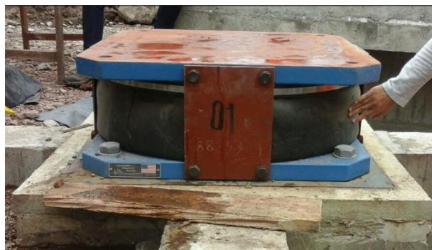
Figura 7. Aislador FPS de tercera generación.
