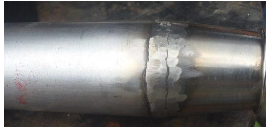
Figura 31 Acabado final del proceso de soldadura tubería de 2plg
