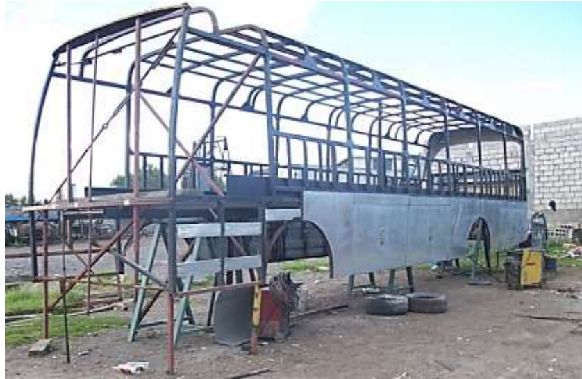
Figura 5 Armazón estructural de la carrocería de bus
