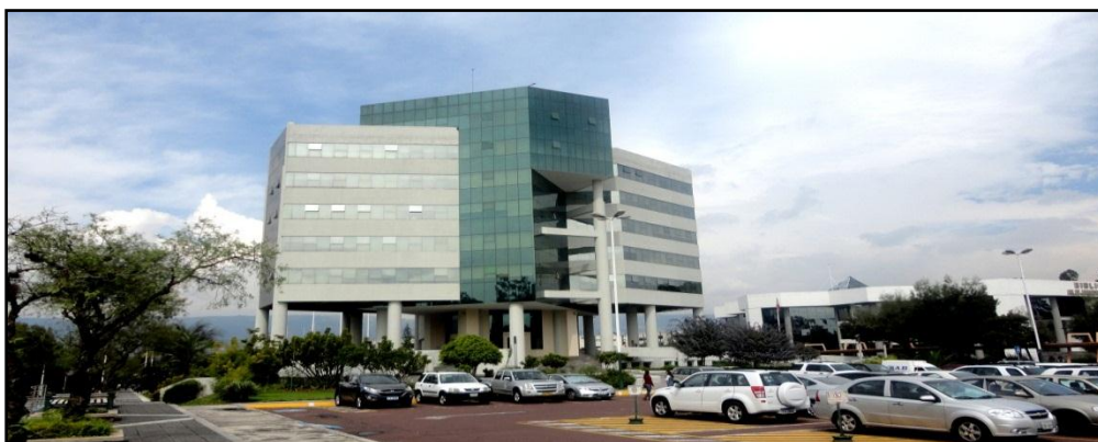
Figura 57 Parqueadero Edificio Administrativo Espe-Sangolquí
