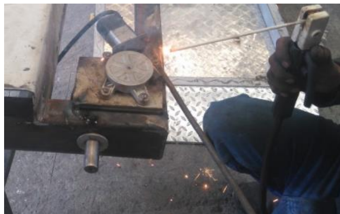
Figura 59. Soldadura en los brazos de seguridad
