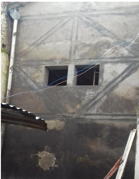
**Figura 65.** Refuerzo en muro tipo cercha
