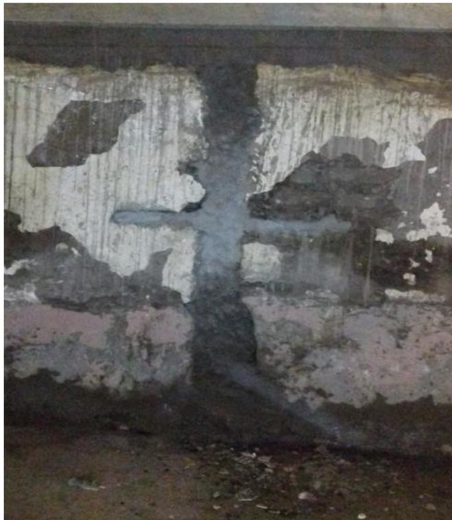
**Figura 64.** Refuerzo en muro tipo cruz
