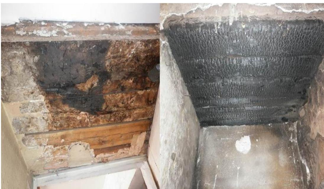
**Figura 28.** Techo afectado debido al incendio
