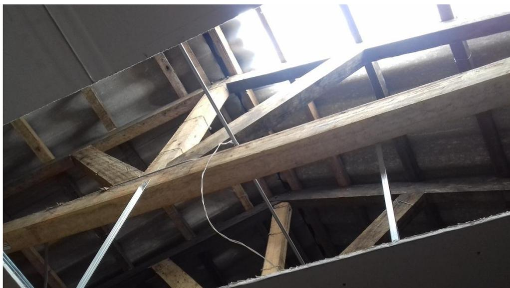
**Figura 35.** Sistema de vigas de techo en madera
