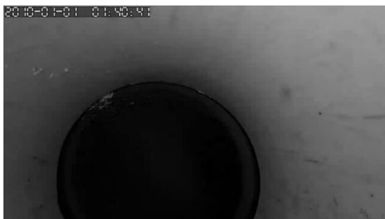
Figura 139 Inspección de la tubería entre la unión del codo de 90° y la tubería recta
