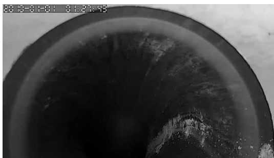
Figura 137 Inspección de tubería sin sólidos
