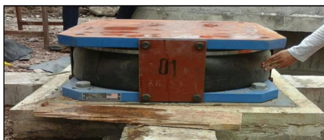
Figura 25 Aislador FPT Implementado en el CICUFA
