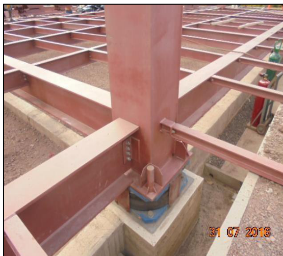
Figura 33 Vista de un Aislador con su Zanja de Acceso
