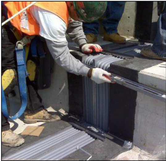
Figura 48 Verificación de que los Sustratos queden Planos
