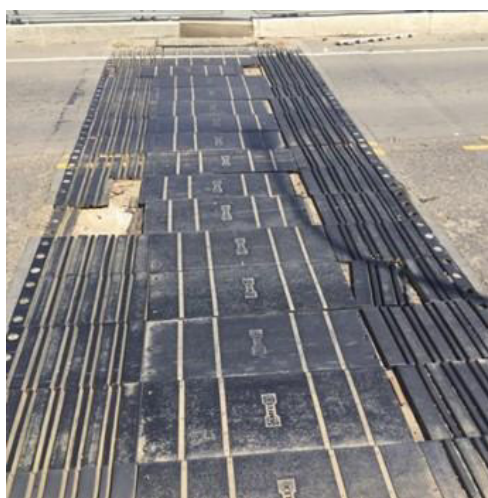
Figura 75 Detalle del sello JSGD después del Terremoto del 16 de abril del 2016
