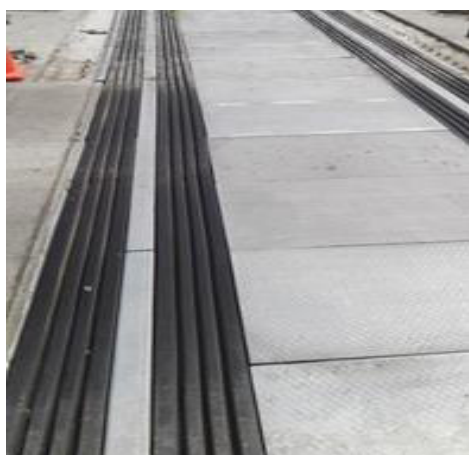
Figura 77 Nueva Versión de la JSGD colocado en el Puente Los Caras
