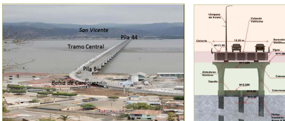
Figura 64 El Puente Los Caras
