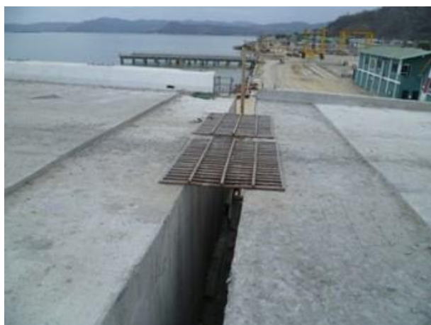
Figura 70 Abertura Estructural Libre del Sello JSGD (50 cm para la Intensidad MC)
