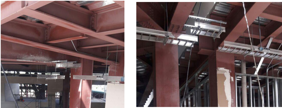
Figura 37 Juntas en Instalaciones Eléctricas
