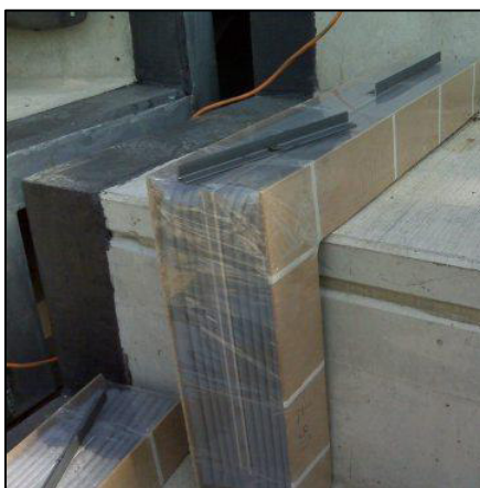
Figura 46 Junta SMS en Proceso de Instalación
