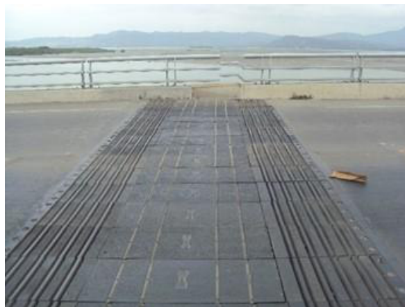
Figura 72 Detalle del Sello JSGD (año 2010)
