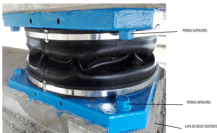
Figura 34 Partes del aislador que se removerá para el reemplazo Fuente: (M. Romo, 2016b)
