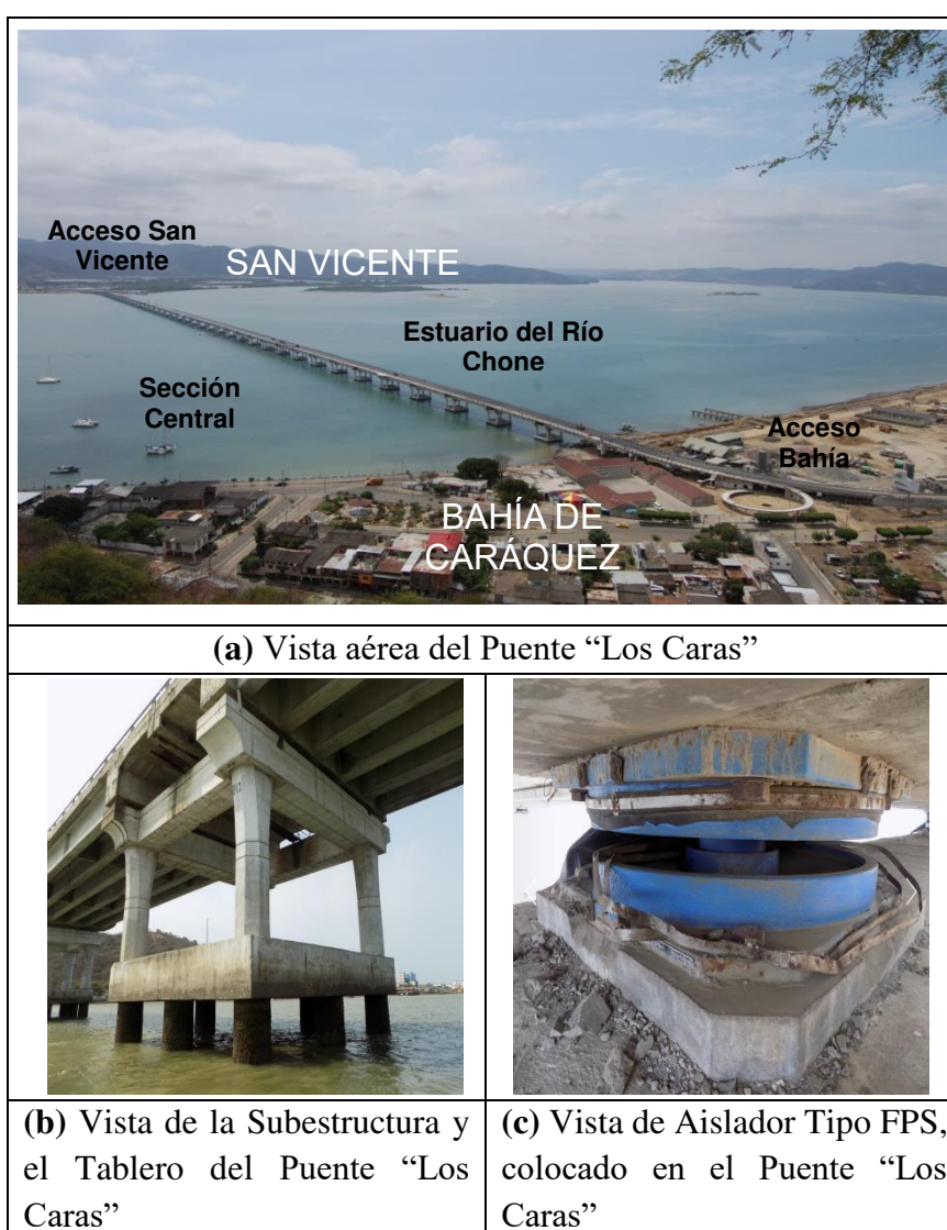
Figura 3 Imágenes del Puente “Los Caras” y su diseño estructural con aisladores sísmicos.
