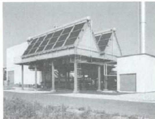
Planta de condensación para el vapor de escape de una turbina.
