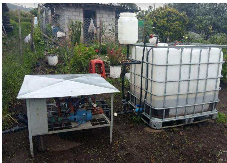
Figura 70. Ubicación de bombas y electrovalvulas.
