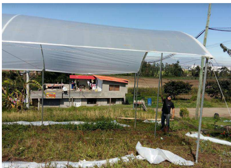
Figura 57. Colocación de plástico
