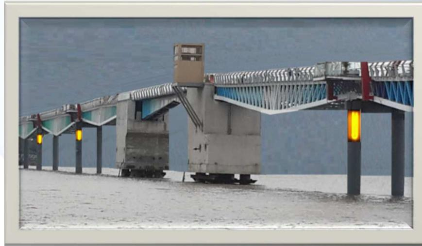
Estas luces amarillas señalizan las columnas como un obstáculo para el marinero y proyecta su luz hacia abajo en dirección a la base de la columna.
