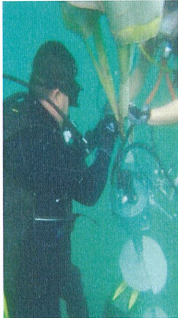
Figura 2.6.15 Colocación boya 1 Fuente INOCAR
