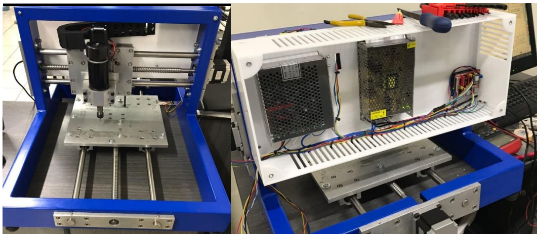
Figura 113 Cableado electrónico del equipo CNC
