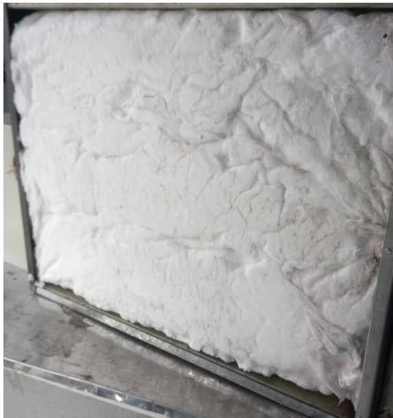
Figura 97. Colocación de aislante térmico en las paredes de la cámara
