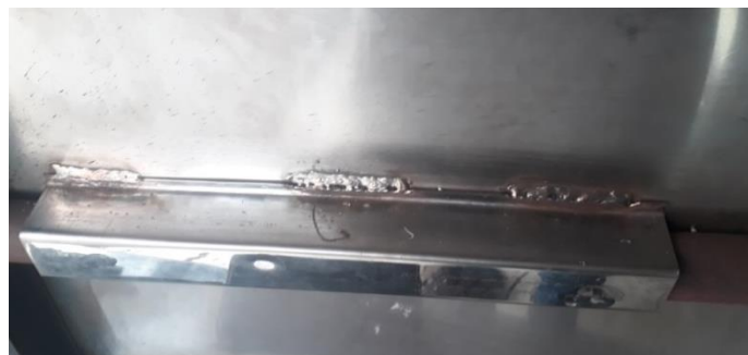
Figura 80. Soporte de resistencia soldado a la cámara
