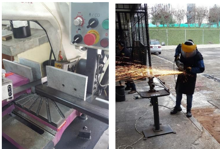
Figura 64 Corte de tubos de acero
