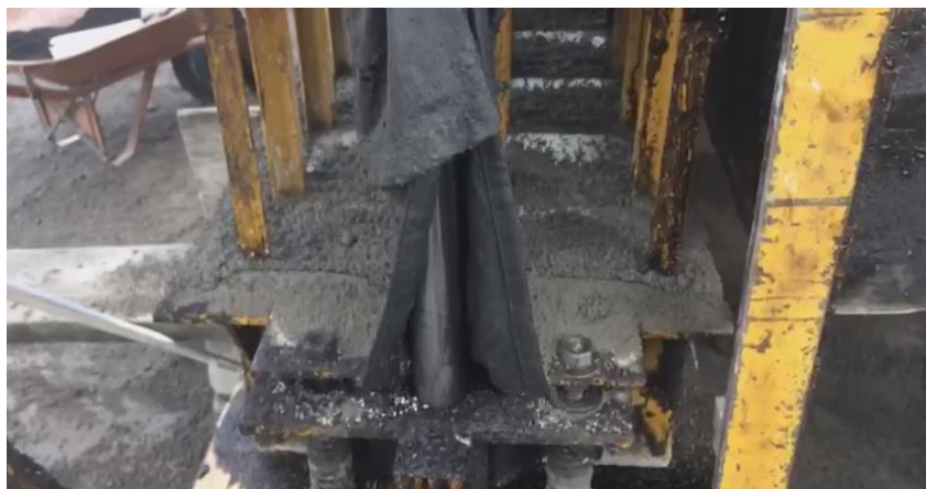
Figura 22. Pisones vibrando el material
