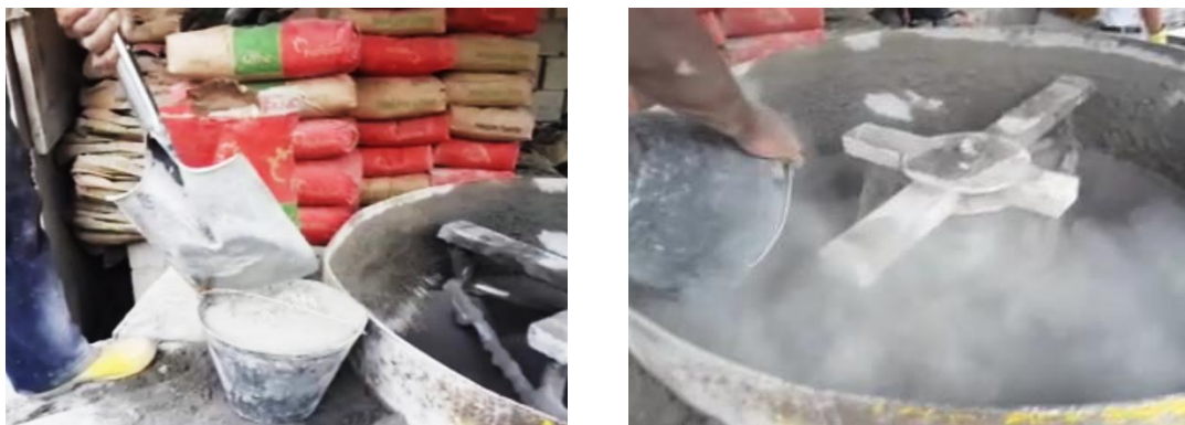
Figura 16. Colocación del cemento en la mezcladora
