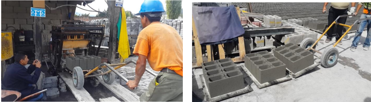
Figura 24. Retiro y transporte de los bloques de la máquina de vibrado
