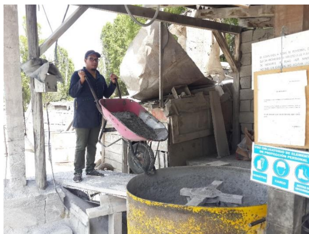
Figura 15. Vertido de la arena en la mezcladora
