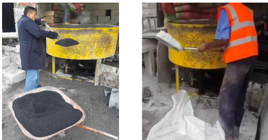
Figura 17. Colocación de fibras de caucho y/o PET en la mezcladora
