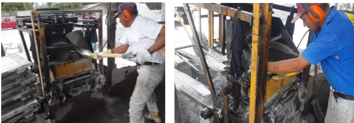
Figura 21. Colocación y distribución del material en los moldes de la máquina vibratoria
