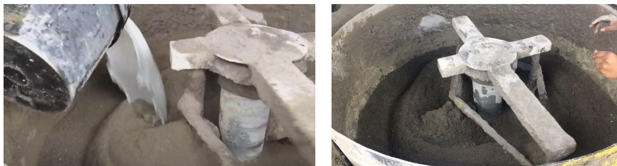
Figura 19. Vertido del agua con resina y prueba de la consistencia de la masa
