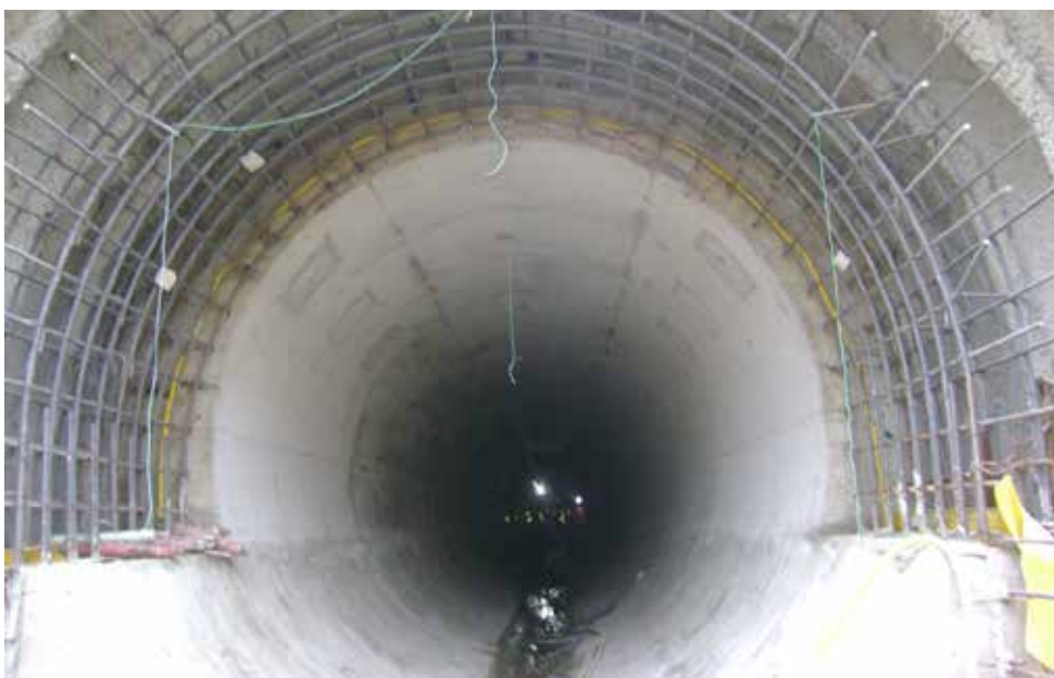
Figura 5.5 Junta de construcción del túnel del Proyecto Río Grande
