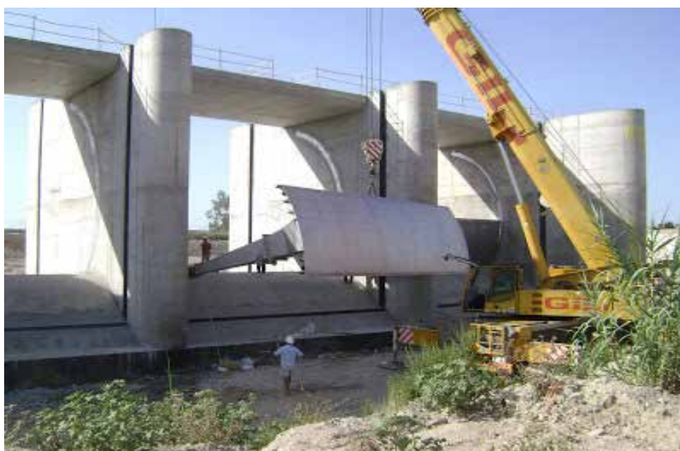
Figura 4.37 Colocación de compuertas Taintor. Fuente: Zambrano (2017)
