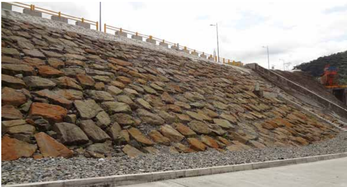
Figura 5.2 Presa de enrocado del Proyecto Coca Codo Sinclair
