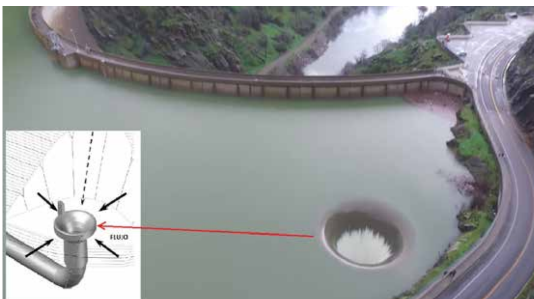
Figura 7.20 Vertedero de labio cerrado, presa Monticello, USA. Fuente: NEWS D. (2017)
