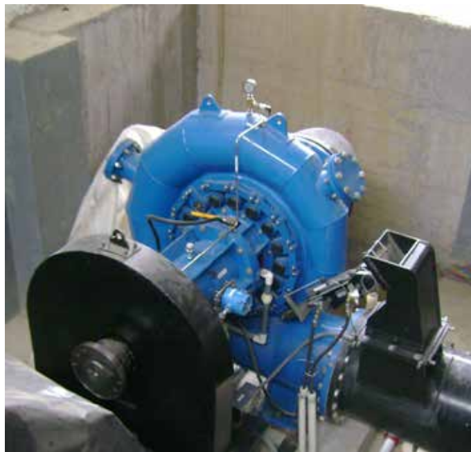
Figura 6.11 Carcasa o Caracol de turbina Francis
