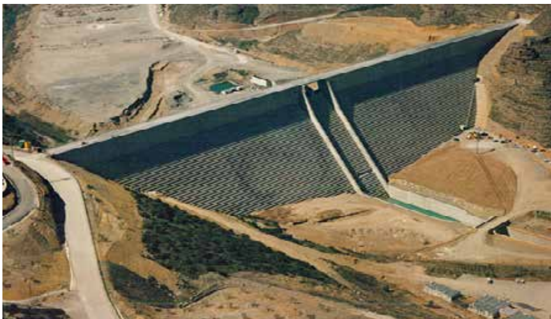
Figura 1.9 Presa de hormigón a gravedad compactado con rodillo. El Val, España. Fuente: CH Ebro (2016)
