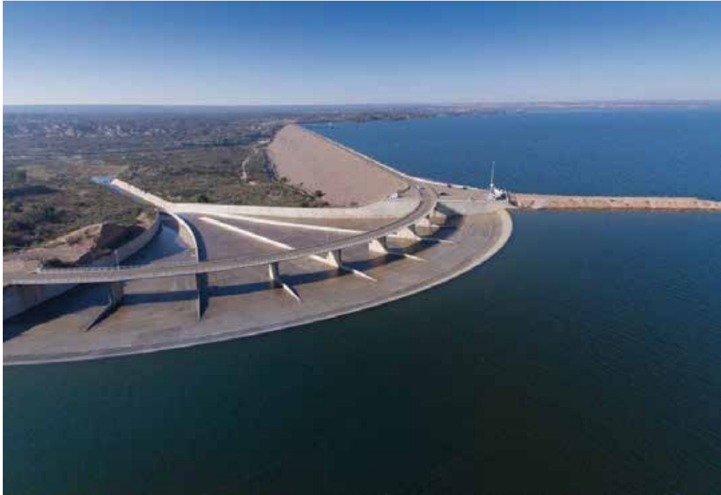
Figura 7.14 Vertedero tipo Abanico de la presa el Carrizal, Argentina. Fuente: Wikipedia
