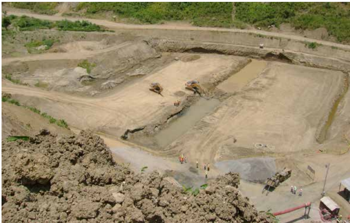
Figura 5.9 Inicio de las obras en la cimentación de la presa Río Grande
