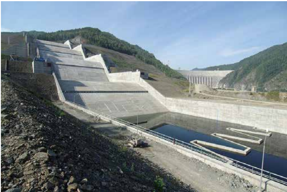
Figura 7.30 Escalones hidráulicos del proyecto Sayano, Rusia. Fuente: PASS-BGCCCH (2012)
