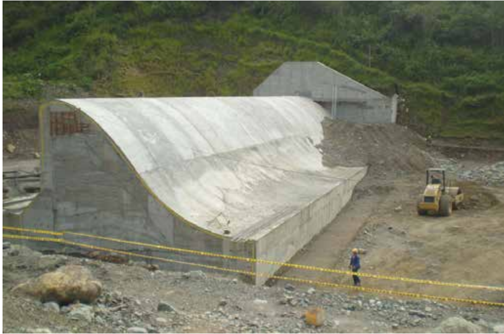
Figura 4.10 Vertedero en construcción. Fuente: Anónima
