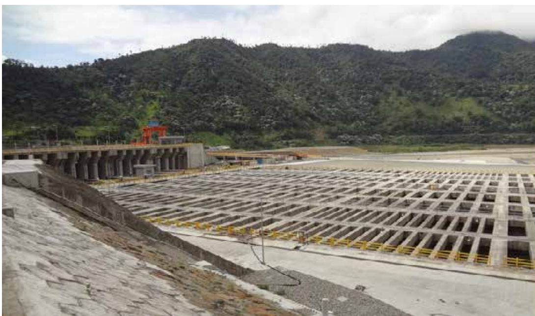
Figura 4.4 Vista de las cámaras de los desarenadores del proyecto CCS.
