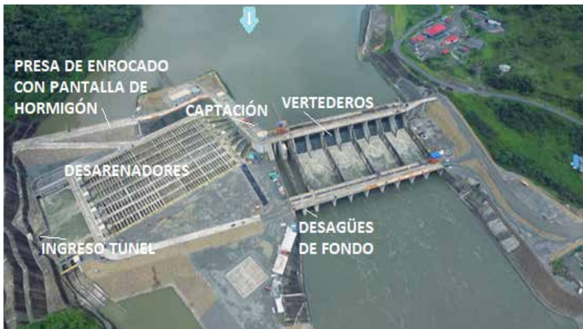
Figura 4.2 Implantación de las obras del proyecto Coca Codo Sinclair. Imagen: Mundo Constructor (2017)
