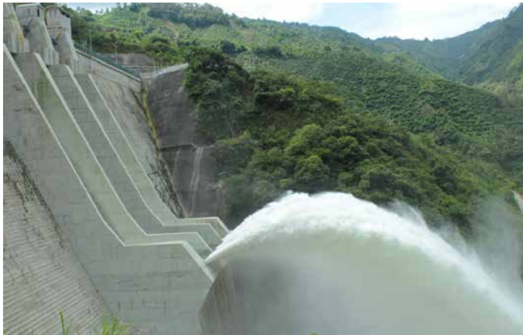
Figura 3.30 Deflectores tipo esquí de la presa Pirrís. Costa Rica. Fuente: Anónima
