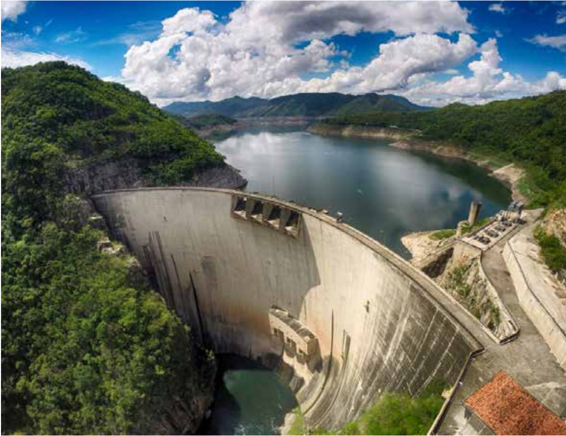
Figura 1.14 Presa de doble curvatura El Cajón, Honduras. Fuente: HIDROVOLCAN (2015)
