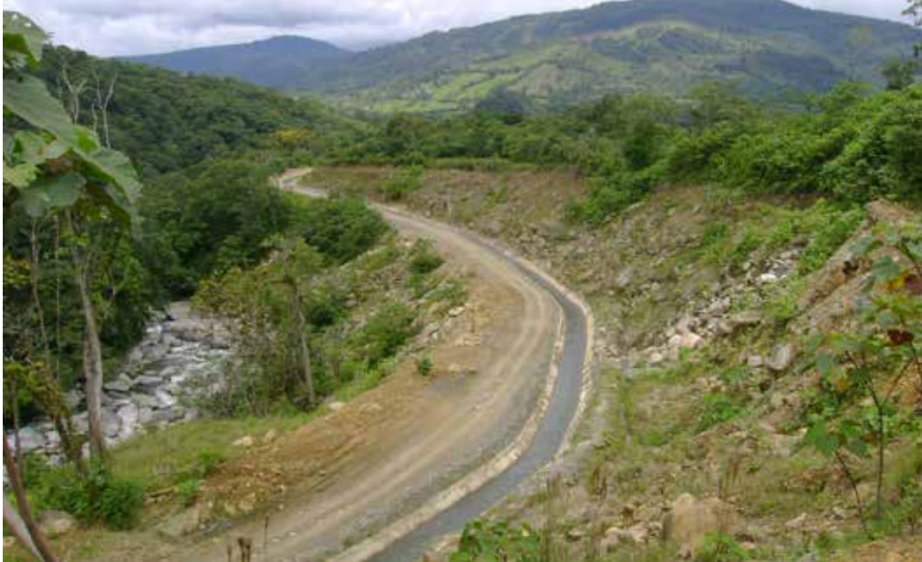
Figura 6.28 Canal con revestimiento de hormigón del proyecto hidroeléctrico Mira
