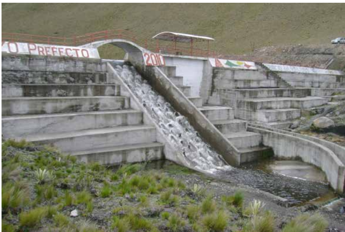
Figura 1.4 Presa de gaviones revestidos de hormigón, Carchi-Ecuador
