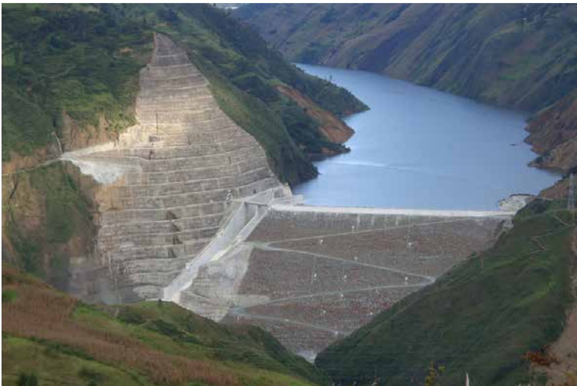
Figura 5.1 Vista desde aguas abajo de la presa del proyecto Mazar.
