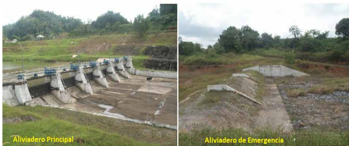
Figura 7.5 Aliviaderos principal y de emergencia de la presa Timah Tasoh, Malasia. Fuente: Nurhuda (2017)
