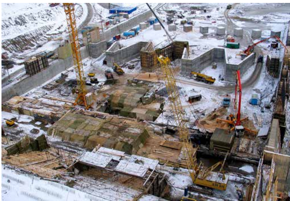
Figura 7.36 Vista de las obras de empate con el canal de salida: Fuente: PASS-BGCCCH (2012)
