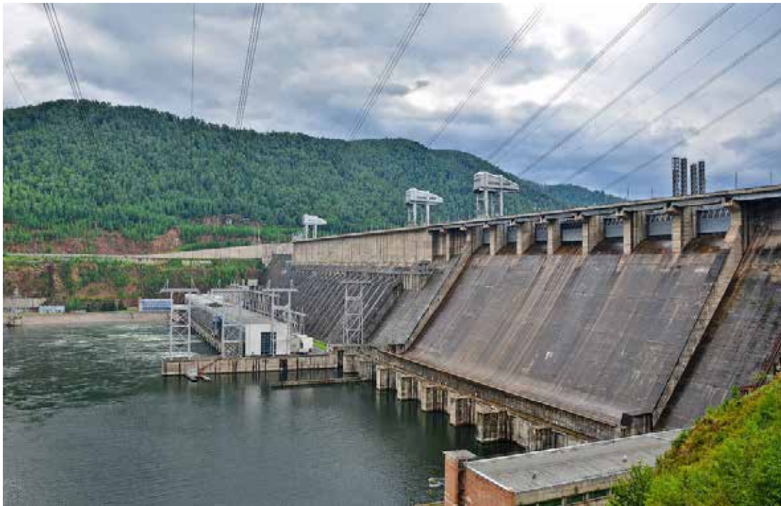
Figura 6.3 Casa de máquinas al pie de presa. Krasnyarscaya, Rusia. Fuente: Stepanov (2011)
