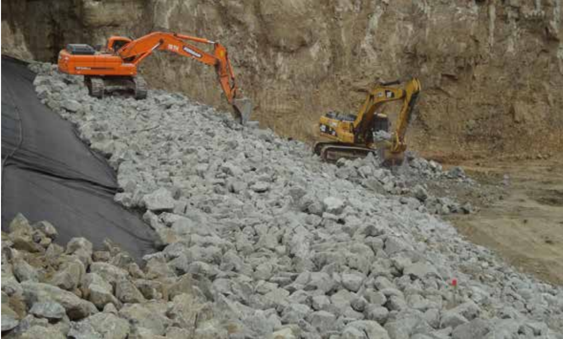
Figura 5.26 Colocación del enrocado (rip-rap) sobre geotextil
