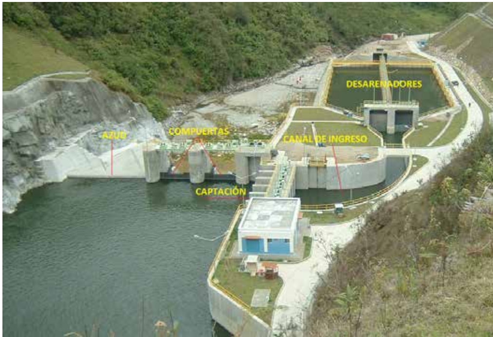
Figura 6.25 Vista de las obras de captación del proyecto San Gabán III, Perú. Fuente: Valdez (2014)
