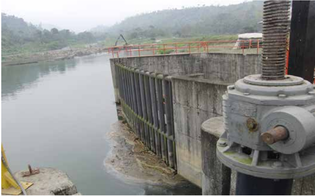
Figura 6.26 Rejillas en la obra de toma del Río Calope
