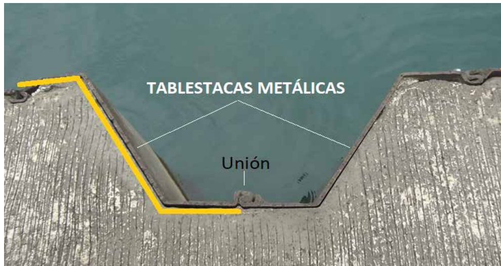
Figura 4.13 Tablestaca tipo z utilizada para puerto marítimo
