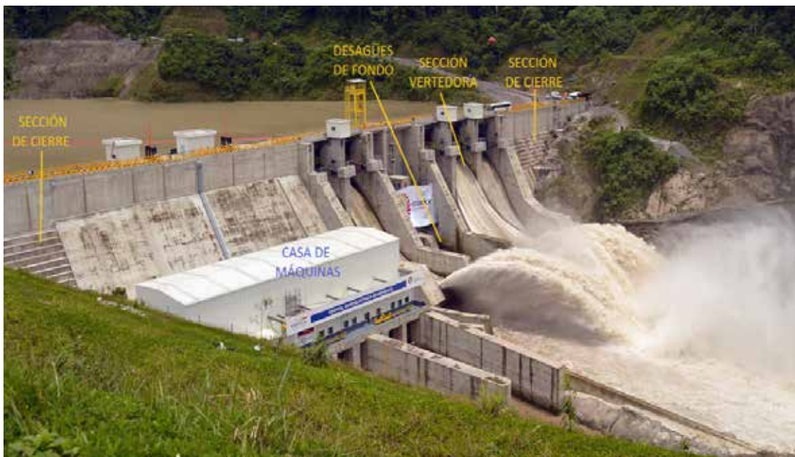
Figura 1.8 Elementos principales de una presa. Fuente: CELEC (2015)
