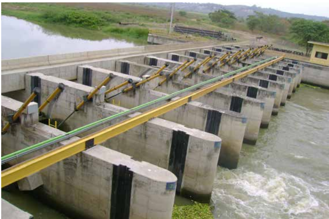
Figura 4.6 Presa de regulación Simbocal, Manabí-Ecuador
