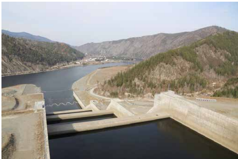
Figura 7.35 Vista del aliviadero hacia aguas abajo. Fuente: Yakunin (2014)
