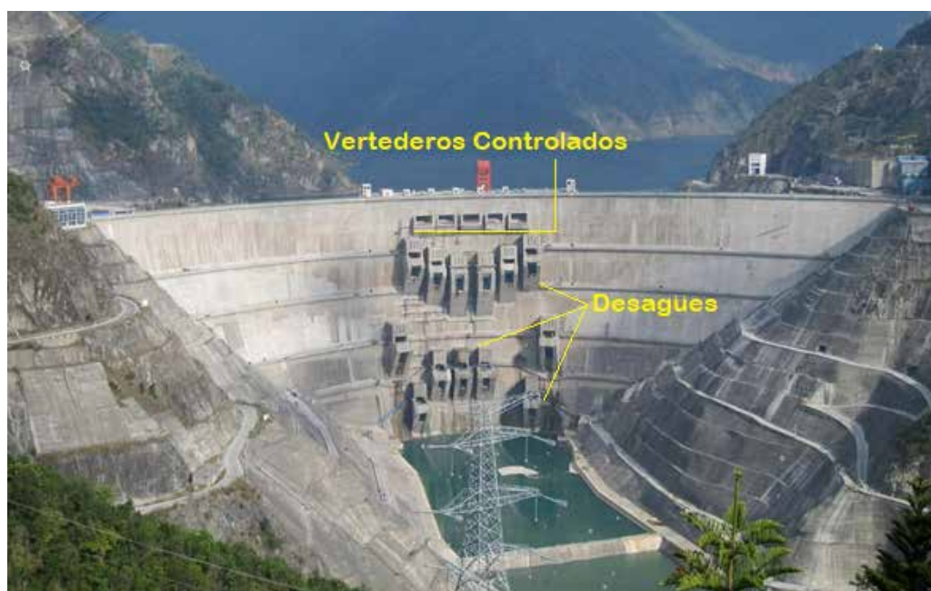
Figura 7.2 Sistemas de descarga a diferentes alturas, Presa Xiaowan, China. Fuente: LifeGlobe (2018)
