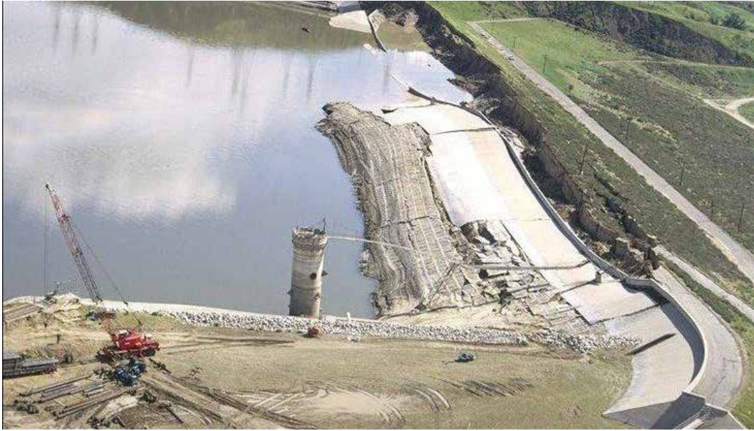
Figura 5.15 Deslizamiento por sismo de la presa Van Norman, terremoto de San Fernando (1971), USA. Fuente: EERC, University of California, Berkeley.
