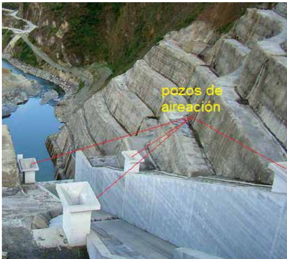
Fig. 7.27 Pozos de aireación en el aliviadero de la Presa Mazar
