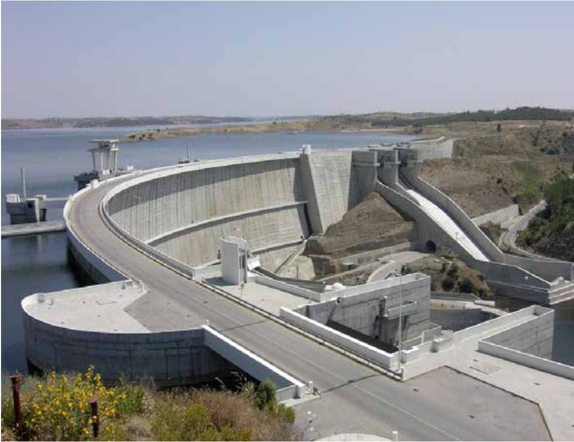
Figura 3.5 Presa en arco Alqueva. Portugal. Fuente: YouTube
