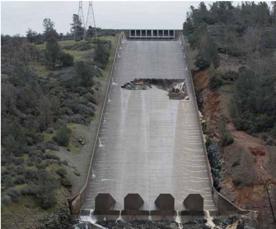
Figura 7.26 Daños en la rápida del aliviadero de la presa Oroville, USA. Fuente: LIVEJOURNAL ( 2017)
