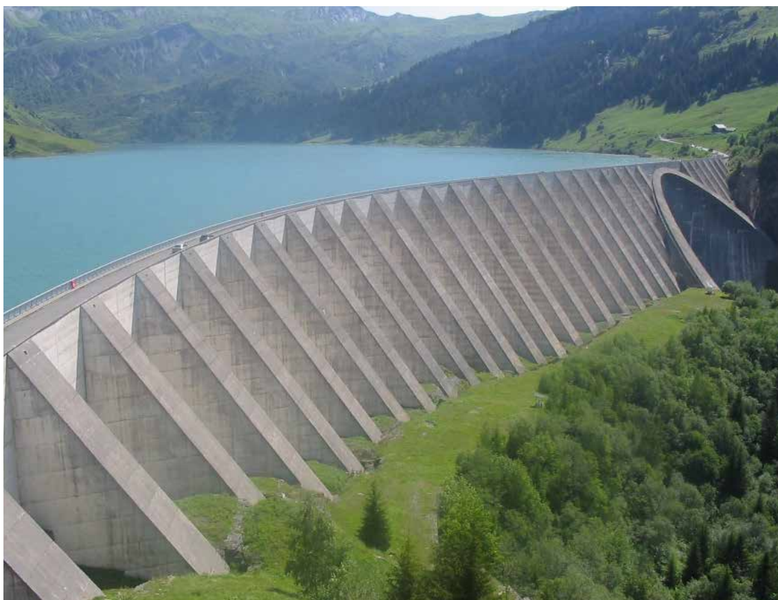
Figura 1.11 Presa de contrafuertes Roselend, Savoie, Francia. Fuente: Versegui (2007)
