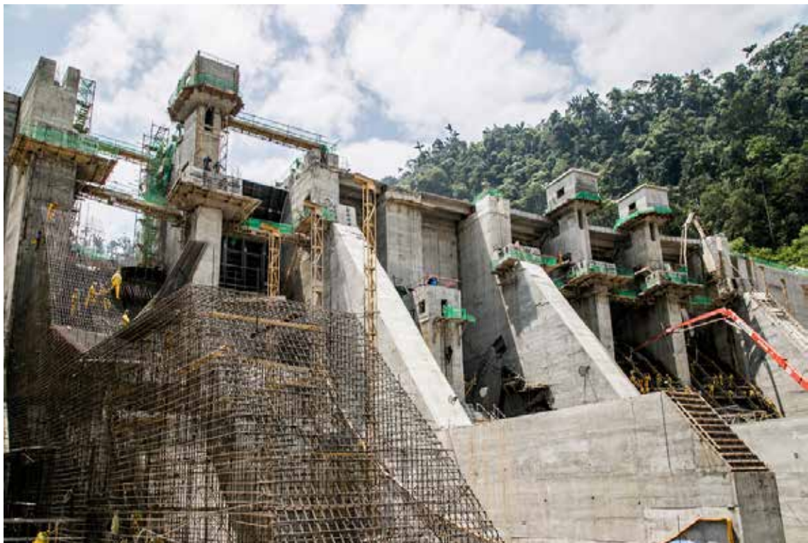
Fig. 3.1 Presa Manduriacu en construcción. Fuente: MEER-EC (2015)
