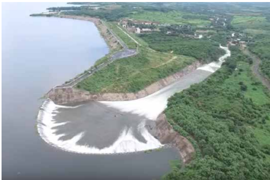
Figura 7.12 Vertedero de abanico de la presa Sanalona, México. Fuente: YouTube
