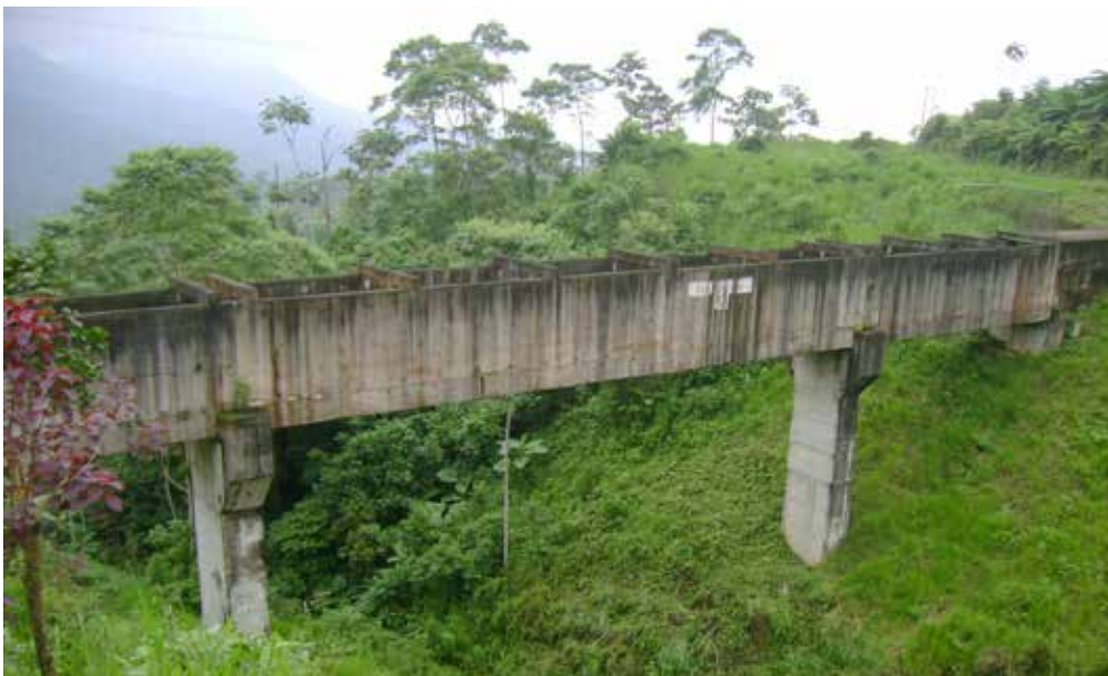
Figura 6.29 Acueducto o puente canal del proyecto del Río Calope
