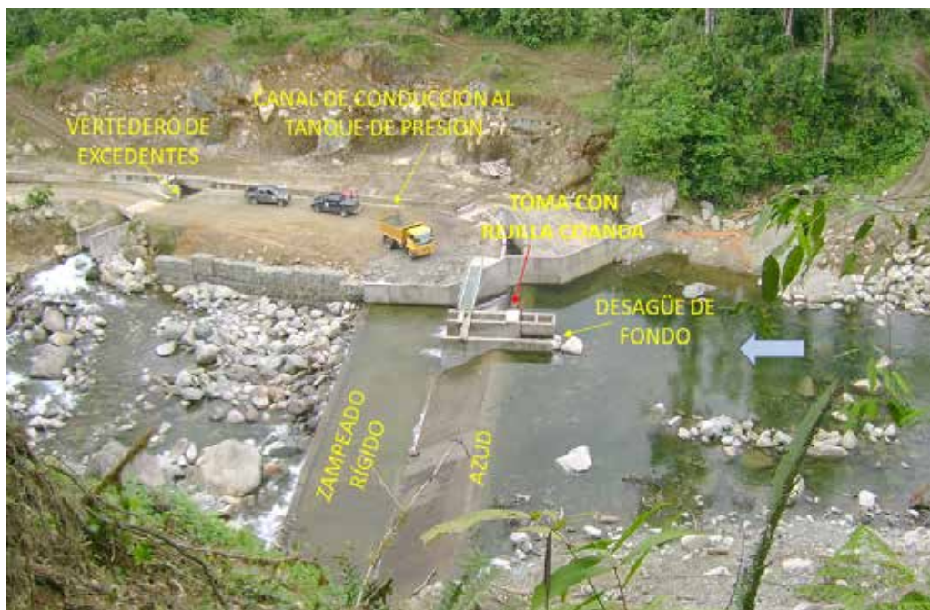
Figura 6.24 Toma de agua del proyecto Mira con rejilla Coanda
