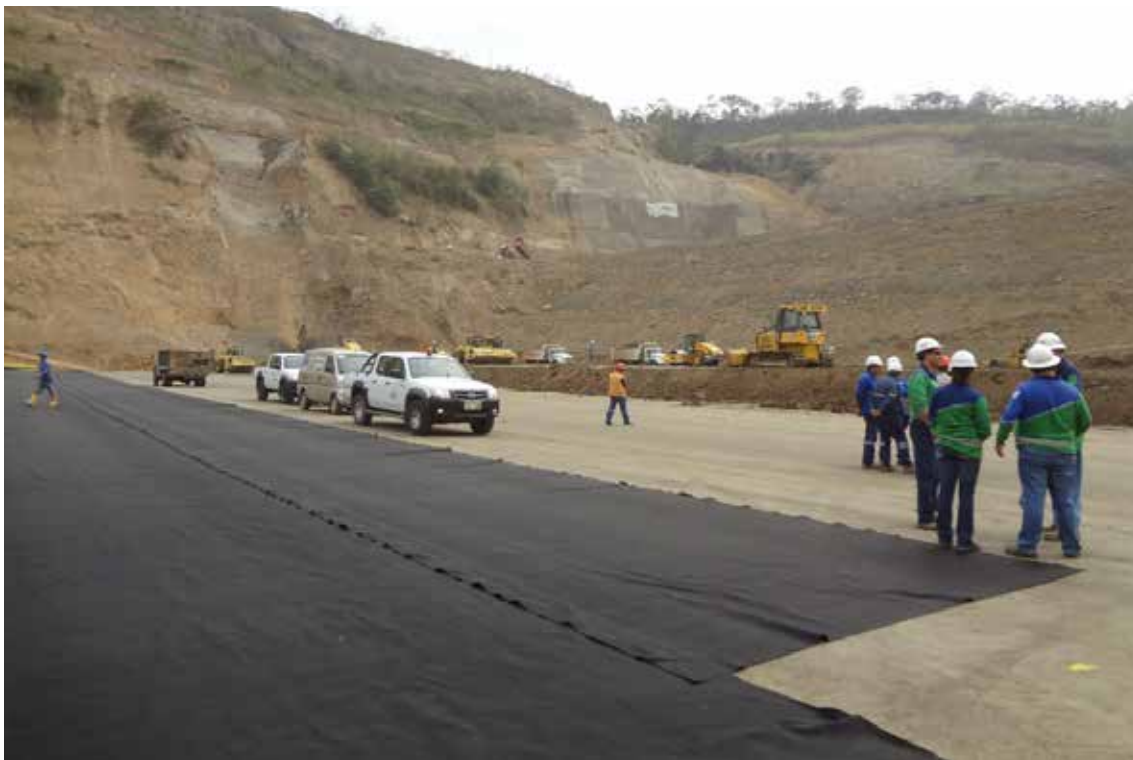
Figura 5.50 Preparación del geotextil para un dren horizontal
