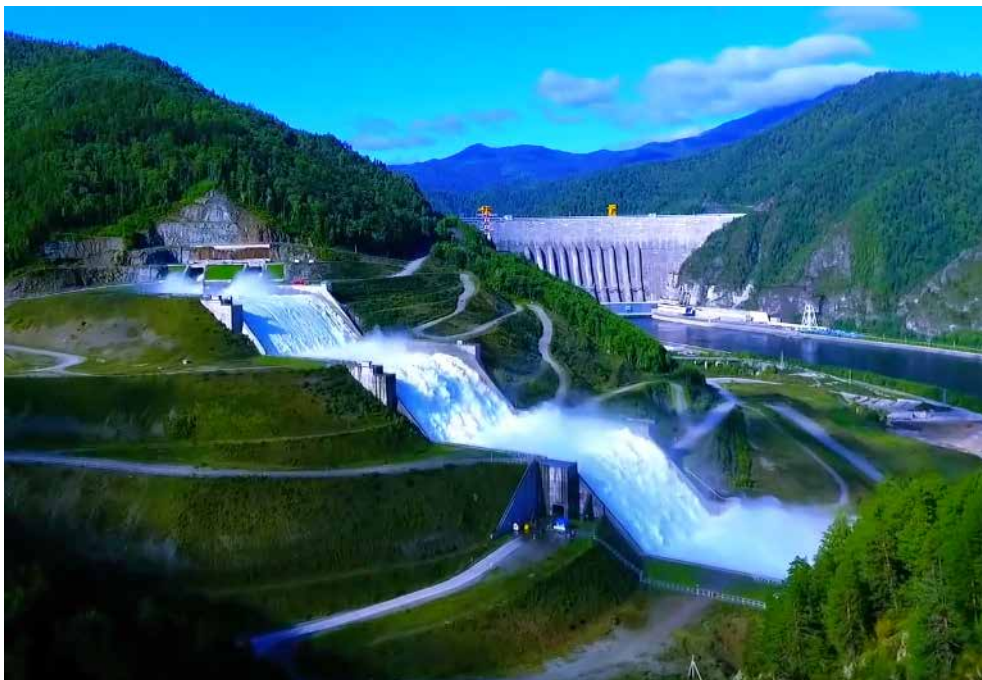
Figura 7.34 Aliviadero escalonado del proyecto Sayano en funcionamiento. Fuente: YouTube (2016)
