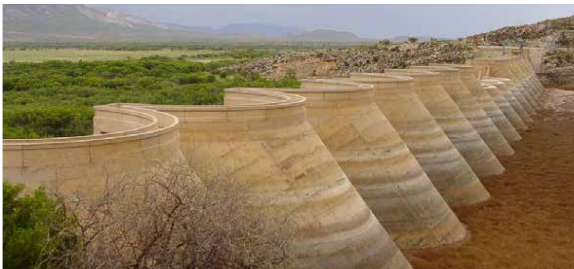
Figura 1.12 Presa de Arcos Múltiples, Sud África. Fuente: SIBVED (2016)
