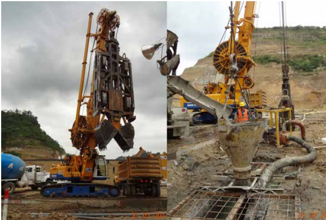
Figura 5.38 Proceso de construcción de la pantalla de hormigón plástico
