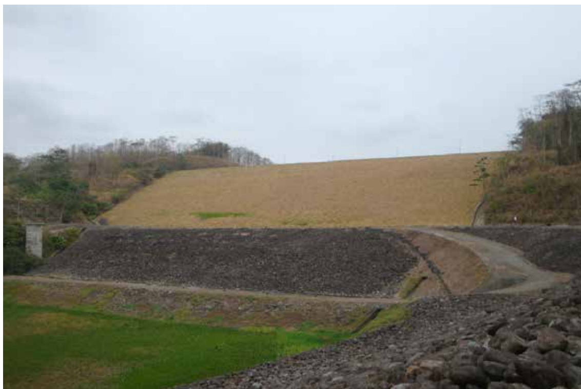
Figura 1.31 Presa de materiales sueltos del proyecto Daule-Peripa
