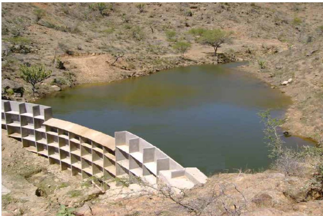
Figura 1.3 Presa de ferrocemento, México. Fuente: Ortiz (2012)
