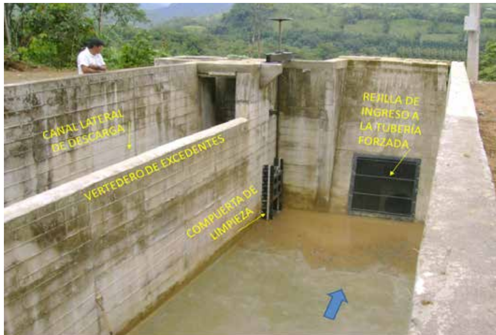
Figura 6.31 Tanque de carga en mantenimiento
