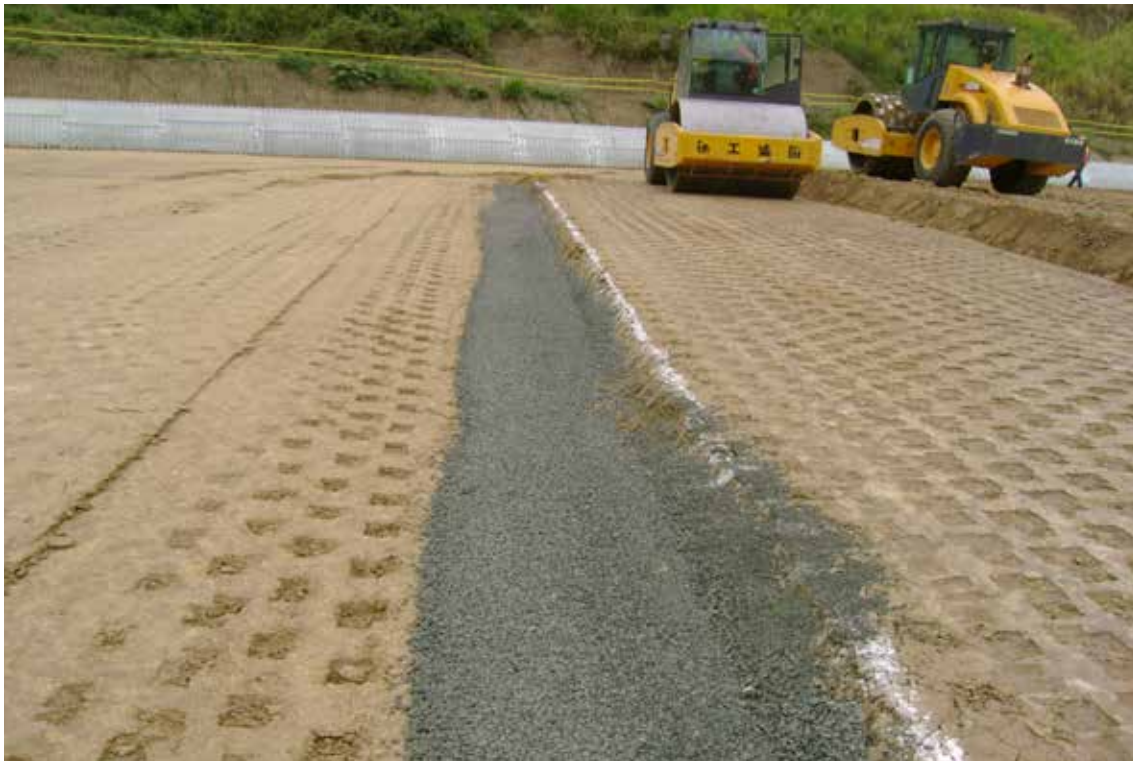
Figura 5.22 Compactación mecánica de una presa
