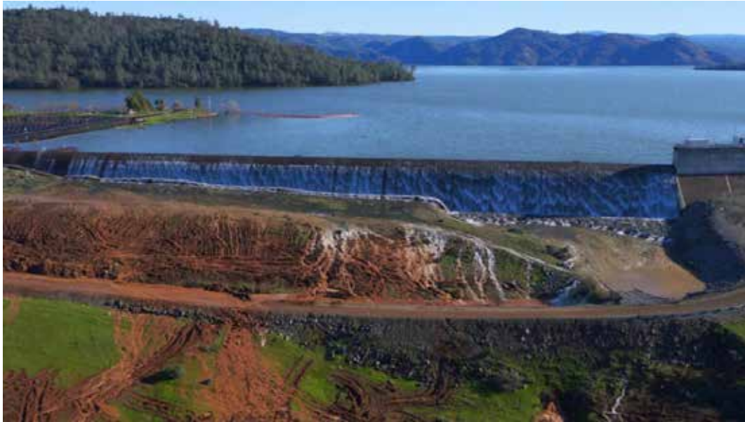
Figura 5.13 Vertedero de emergencia de Oroville Dam, USA. Fuente: Saiga (2017)
