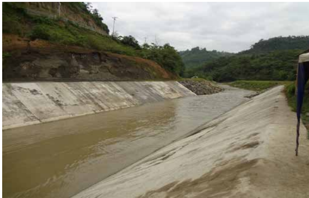
Figura 7.29 Canal de salida del proyecto Río Grande
