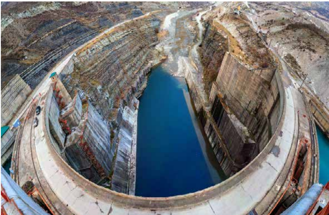
Figura 3.2 Vista de la presa Miatlinskaya, Rusia. Fuente: Popov (2013)
