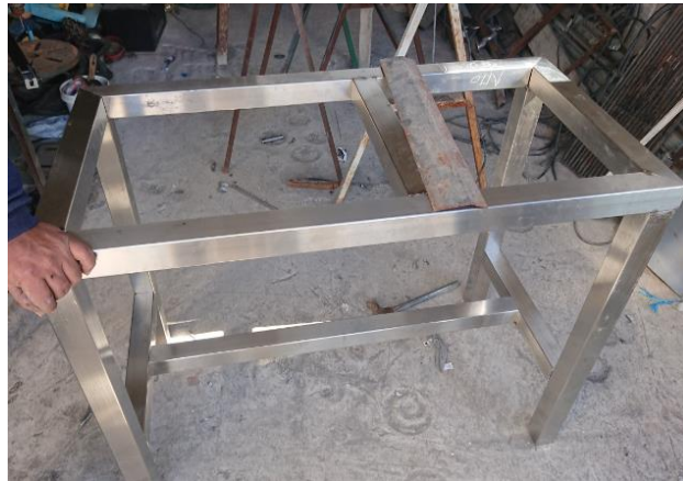
Figura 35. Construcción de estructura de soporte del banco de pruebas
