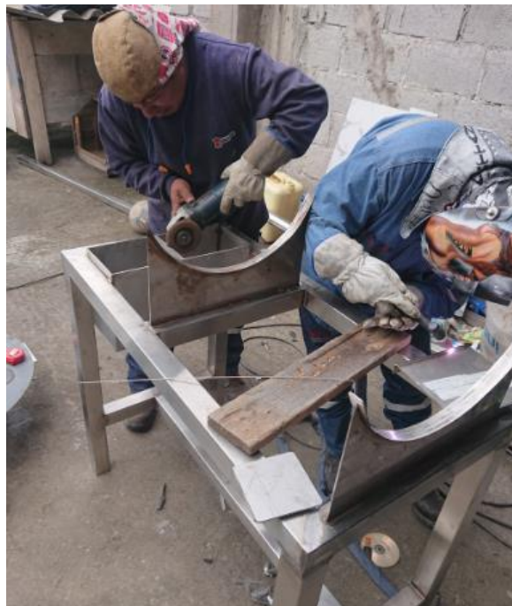
Figura 36. Colocación de las cunas en la estructura de soporte
