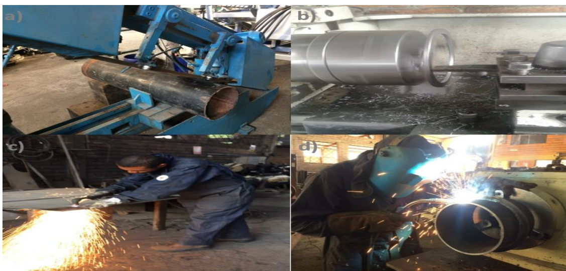
Figura 27 Proceso de construcción en probetas y soportes.
