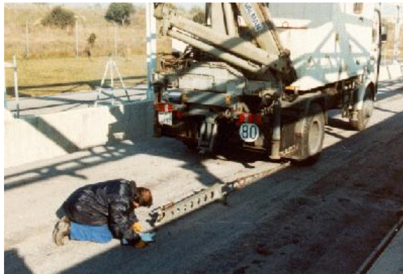
Figura 3.11: Aplicación de la Viga Bemkelman para la determinación de deflexiones
