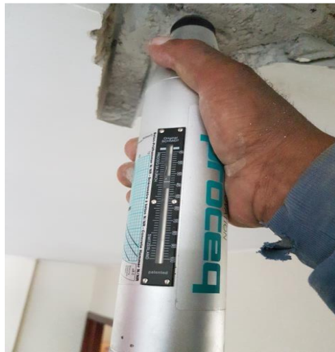
Figura 27. Verificación de resistencia de hormigón en viga
