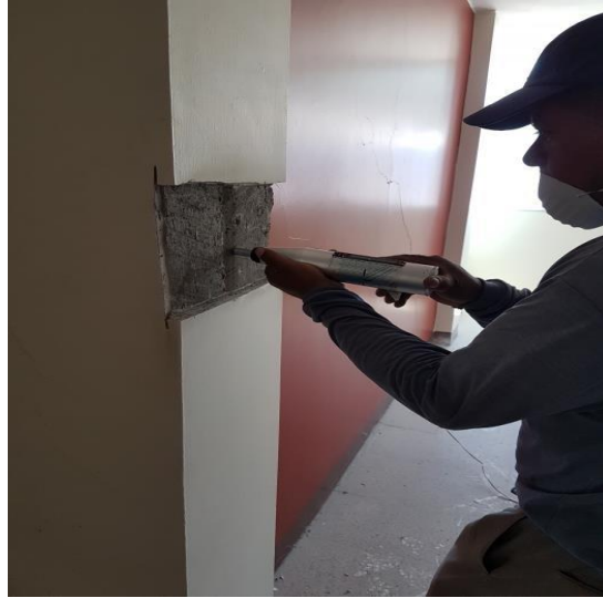
Figura 26. Verificación de resistencia de hormigones con esclerómetro en columna
