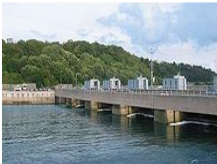
Figura. II.11. Central eléctrica mareomotriz en el estuario del río Rance, Francia 1
