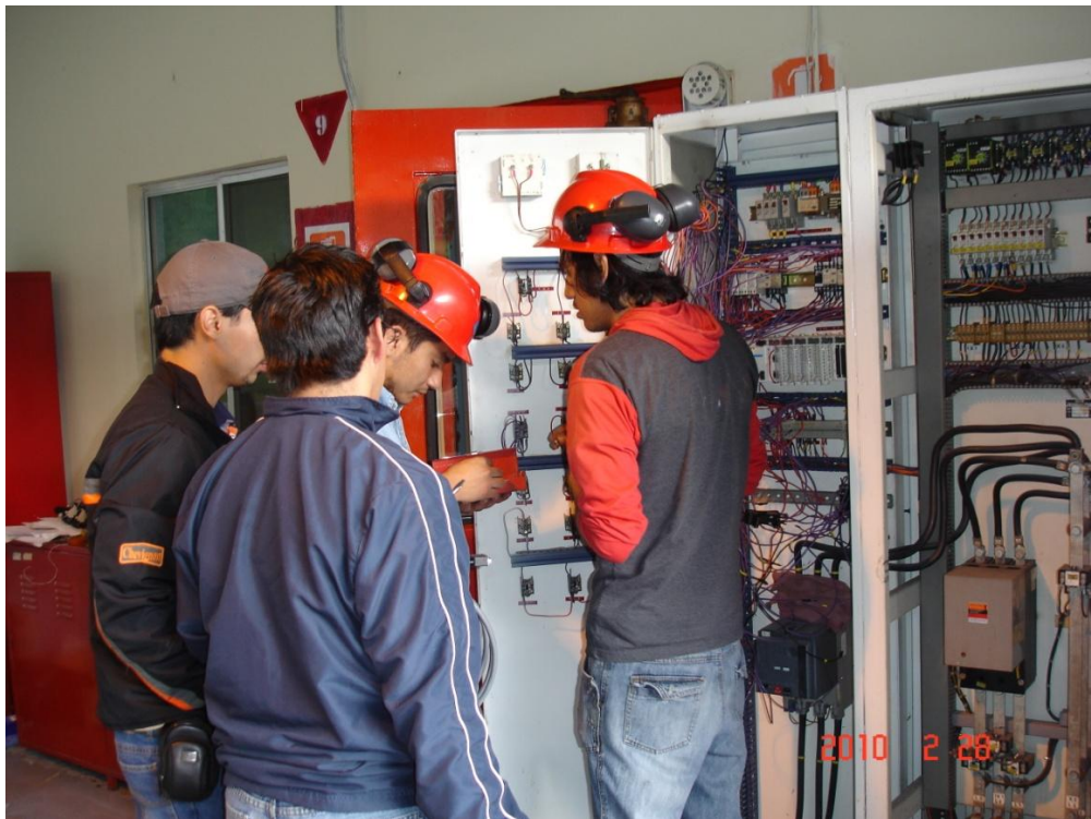
Figura. VII.7. Proceso de Implementación del Tablero de Transferencia (1)
