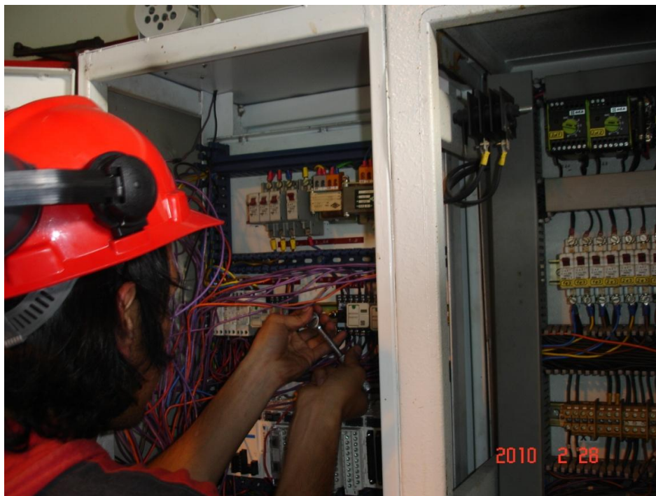
Figura. VII.8. Proceso de Implementación del Tablero de Transferencia (2)
