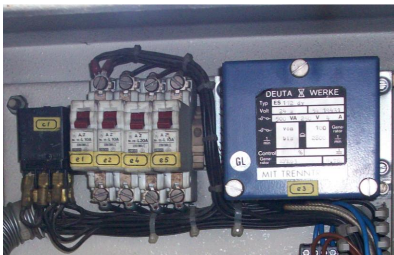
Figura. VII.3 Elementos del sistema anterior conservados en el diseño del nuevo tablero Kuhse
