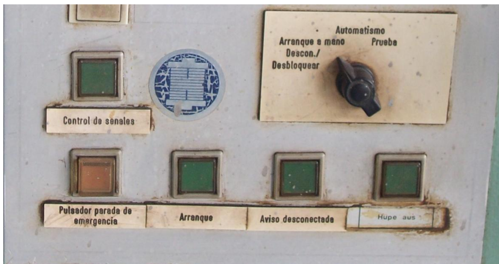
Figura. IV.5. Bloque de pulsadores y switch de selección de modo
