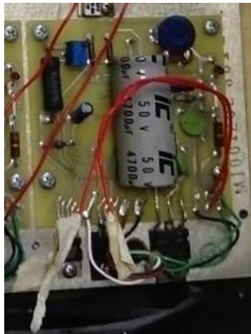
Figura 34 Fuente regulada deshabilitada.
