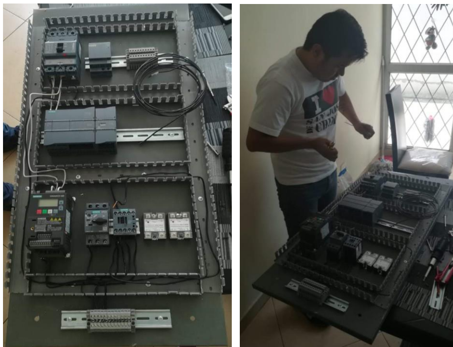
Figura 55. Fijación de elementos y cableado parte de potencia
