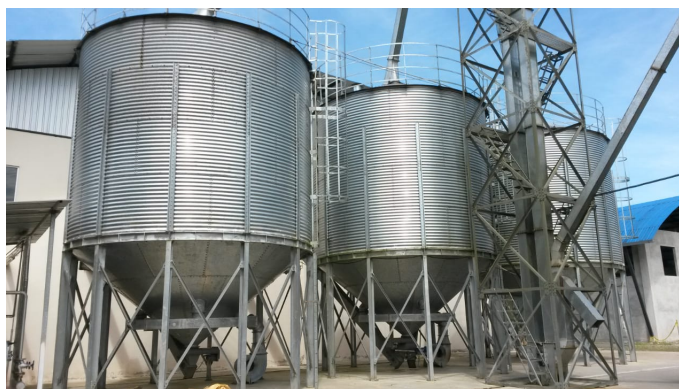
Figura 5. Silos de almacenamiento de materia prima.
