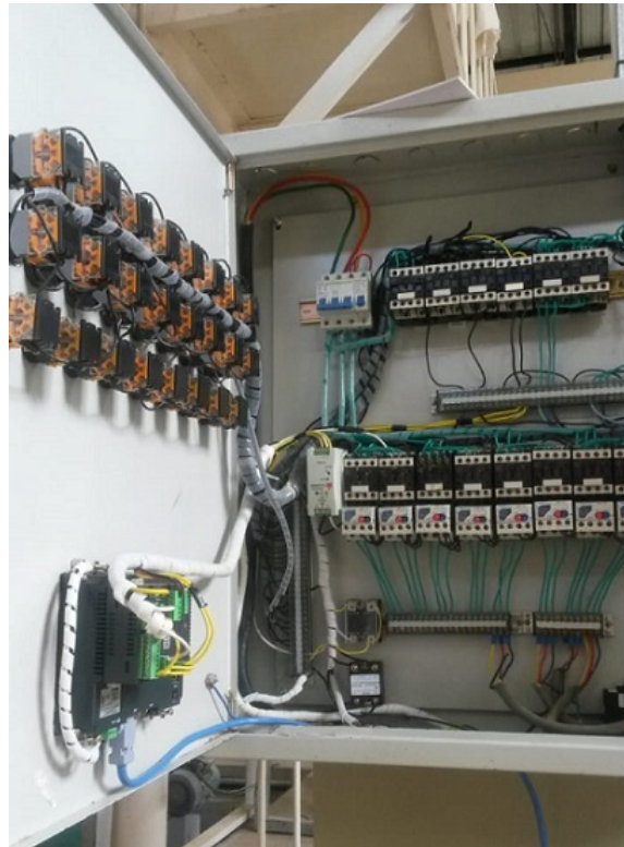
Figura 75. Montaje de elementos en tablero.
