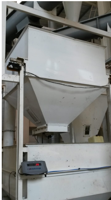
Figura 6. Dosificación por pesaje.
