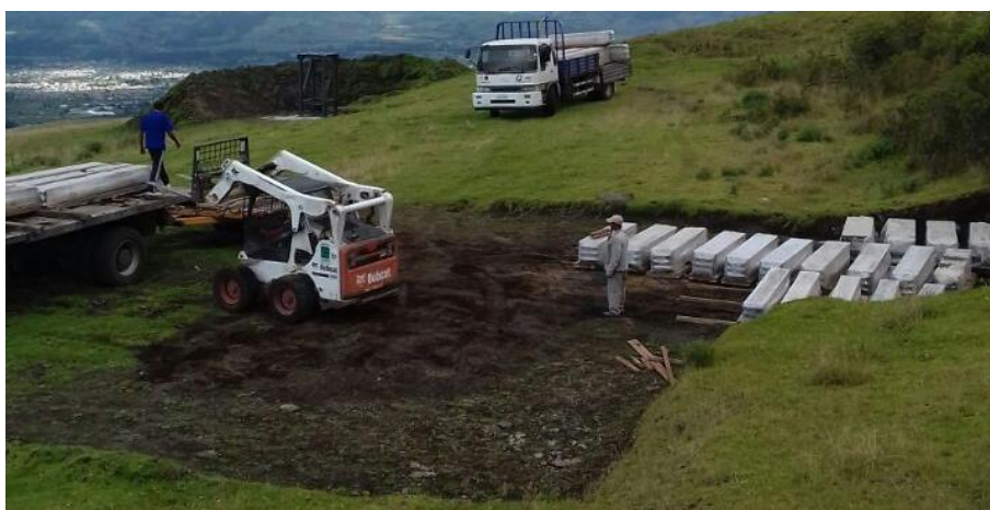
Figura 48. Traslado de las probetas de hormigón armado tipo columnas
