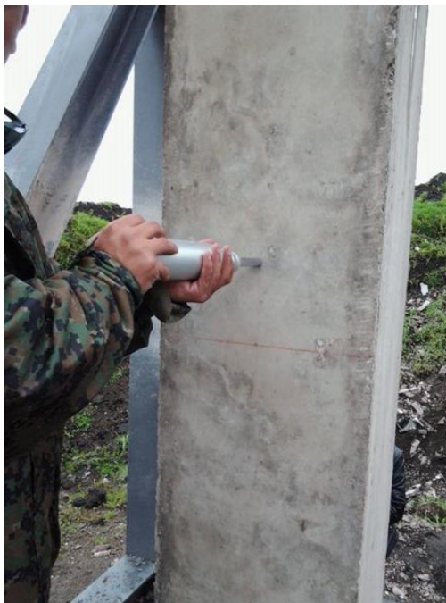
Figura 56. Ensayo de resistencia del hormigón con el uso de esclerómetro
