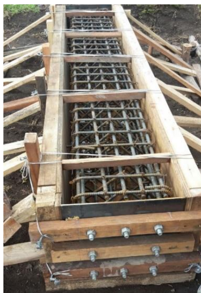
Figura 31. Encofrado de madera Tríplex 4818 C de 3 caras para probetas tipo columna
