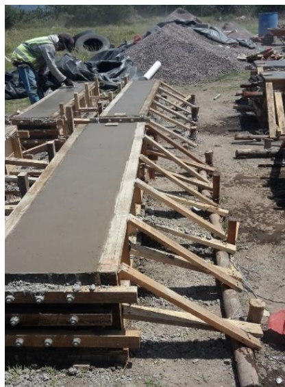
Figura 32. Fundición de probetas tipo columna de hormigón armado
