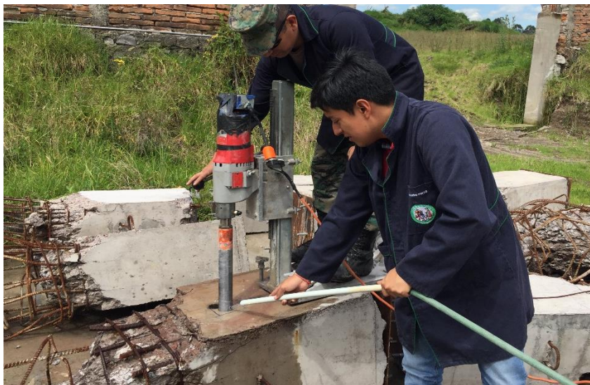
Figura 63. Perforación de los núcleos en las probetas tipo columna
