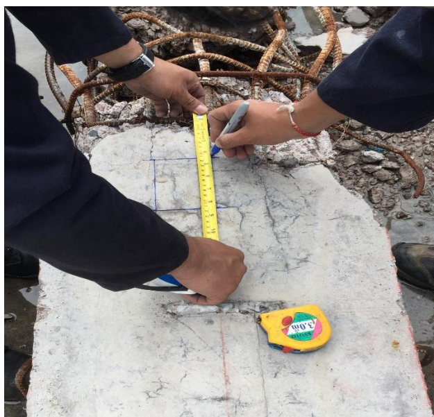
Figura 64. Medición del área de perforación
