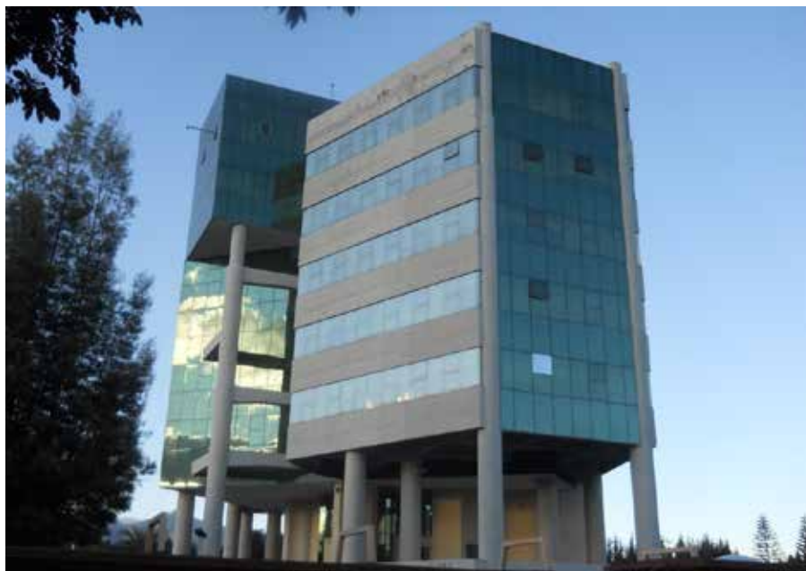
Diseño arquitectónico: Arq. Hugo Ayala. Diseño estructural: Ing. Pablo Caiza (2004) BIBLIOTECA ALEJANDRO SEGOVIA
