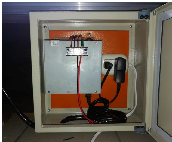
Figura 94 Montaje de la fuente de poder en la caja electrónica
