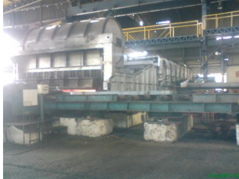
Figura 2.16. Horno de precalentamiento
