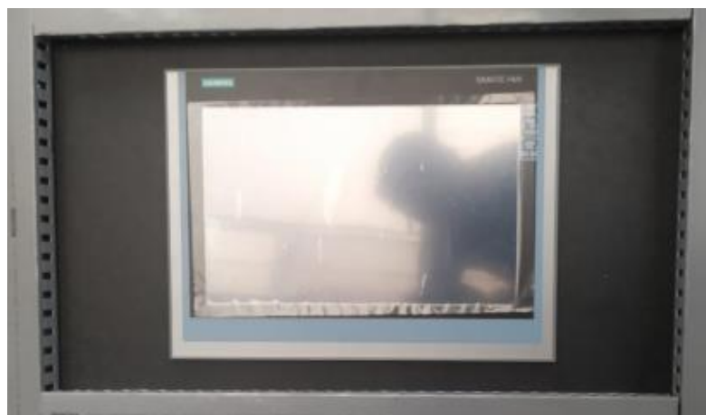
Figura 49. Implementación del Rack 2
