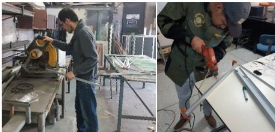
Figura 139. Ensamble de la estructura de la cabina.
