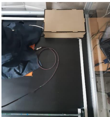
Figura 138. Canaletas para cables.
