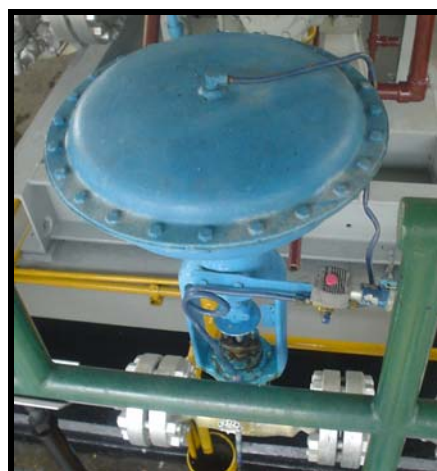
Figura 2.5. Válvula de recirculación de combustible
