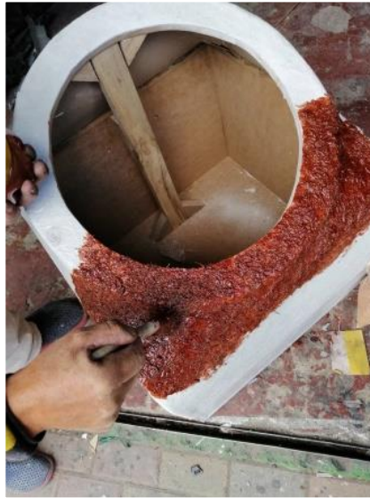
Figura 40. Colocación de material compuesto de fibra de coco
