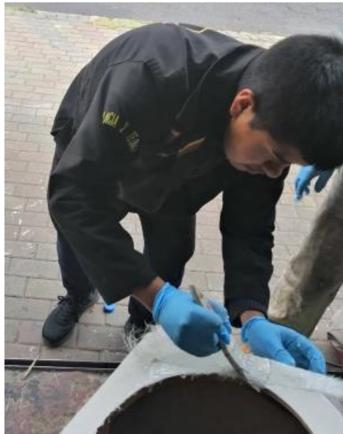
Figura 39. Colocación de fibra de vidrio con polvo de balsa
