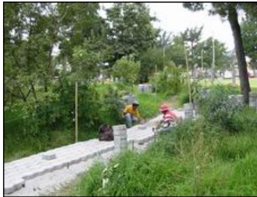
Gráfica No. 4: Construcción de las lagunas
