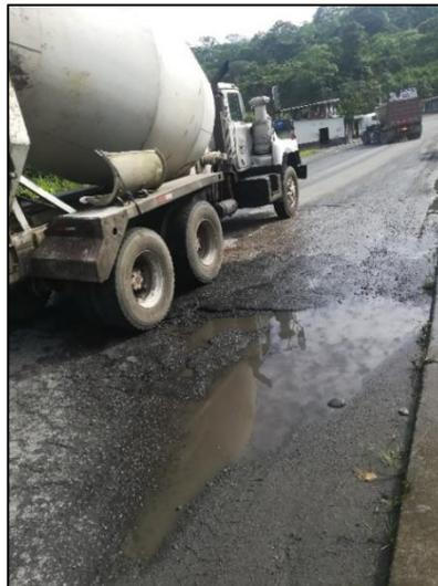
***Otros daños en pavimentos flexibles******Pérdida de agregado (PA)***
