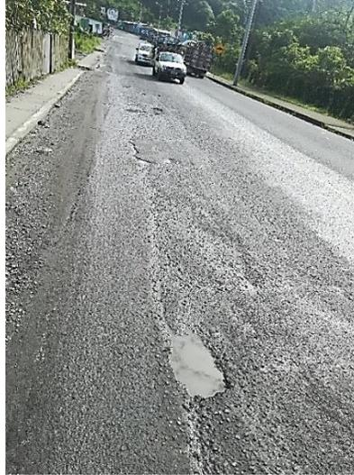
***Pérdidas de las capas de la estructura.*****Descascaramiento (DC)**
