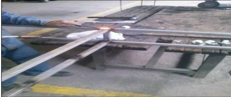
Fotografía. Unión de la estructura mediante soldadura
