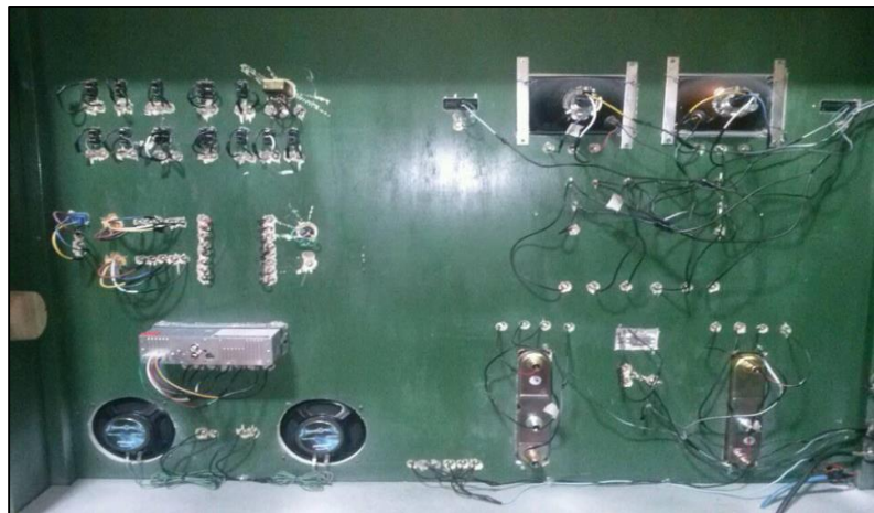
Figura 40. Montaje de la pre-conexión
