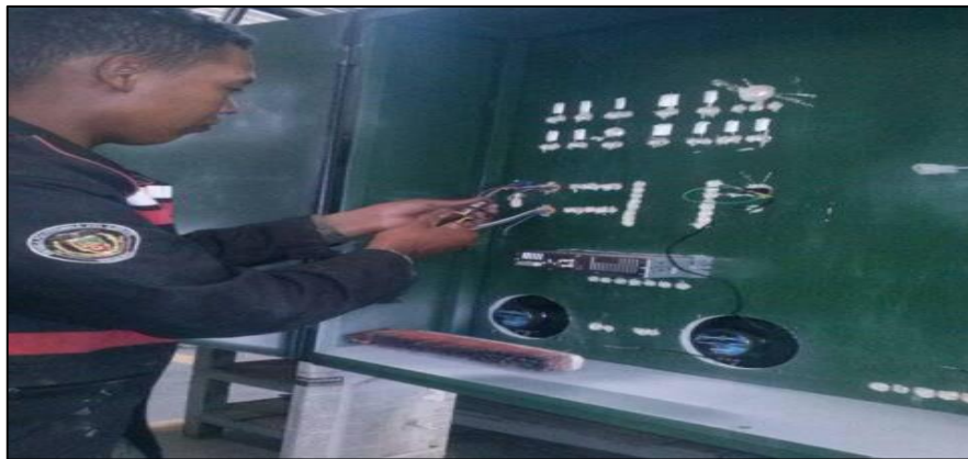
Fotografía. Instalación de los circuitos
