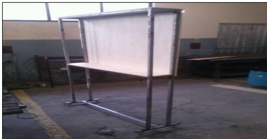
Fotografía. Colocación de los paneles frontales y laterales
