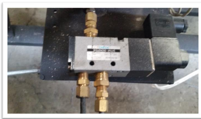
Figura 42 Colocación de la electroválvula
