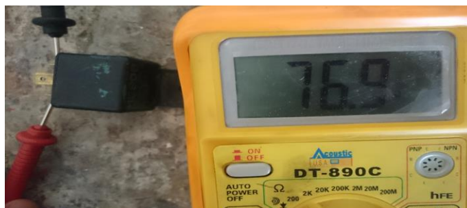
Figura 82 Resistencia del relé del electro ventilador
