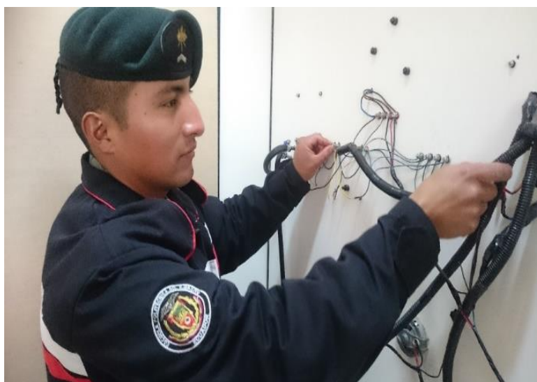
Figura 49 Instalación eléctrica del sistema de inyección
