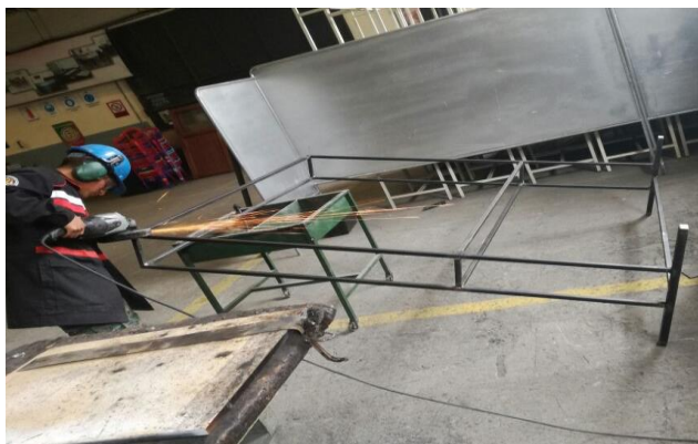
Figura 39 Soldadura y pulida de la estructura
