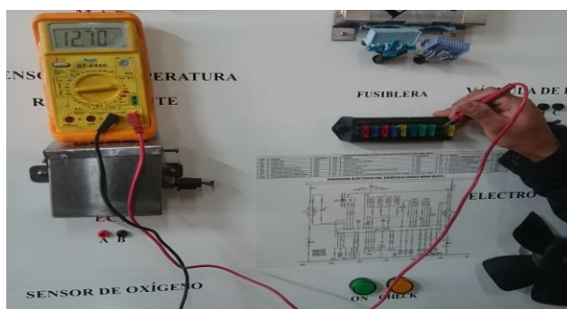
Figura 52 Verificación de la alimentación directa
