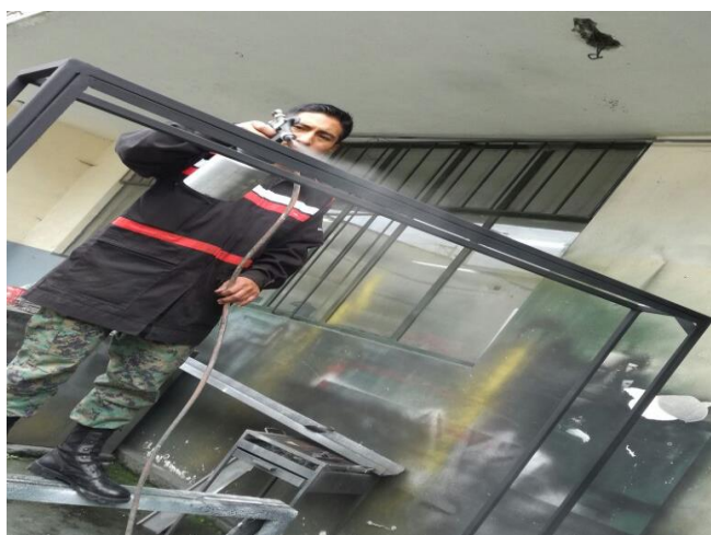
Figura 40 Pintura de la estructura del banco de pruebas
