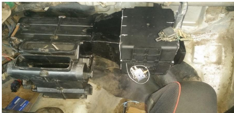
Figura 62 Instalación del evaporador
