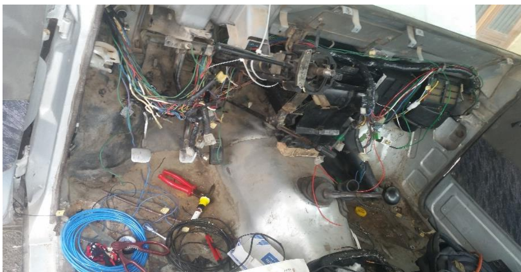
Figura 67 Instalación del cableado dentro del habitáculo
