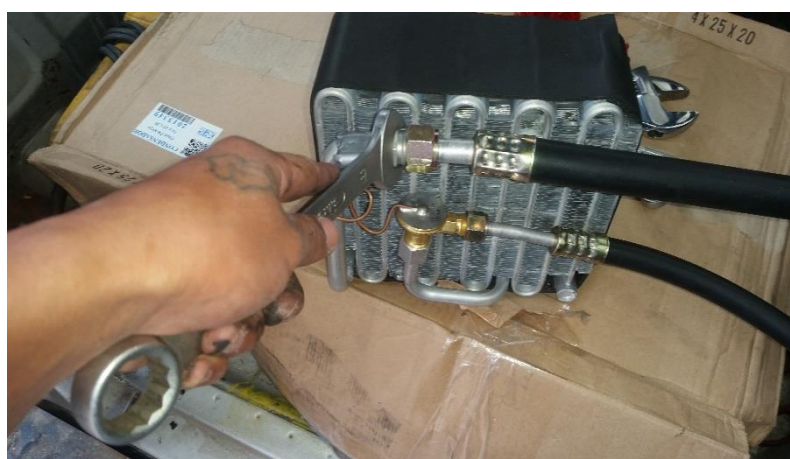
Figura 61 Instalación del expansor y cañerías
