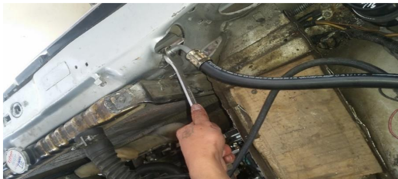
Figura 63 Instalación de cañerías
