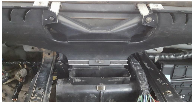
Figura 74 Instalación de los ductos de calefacción y A/C
