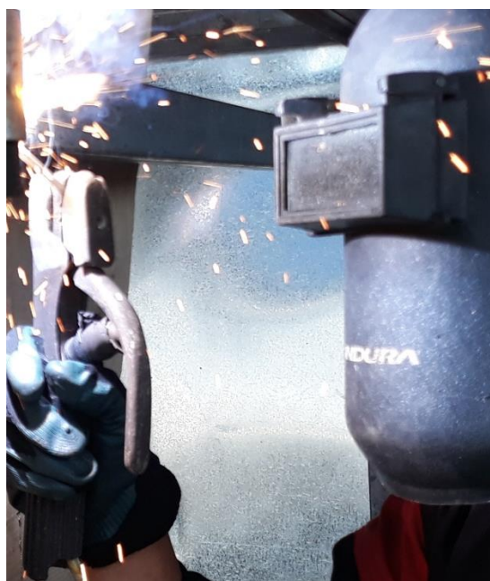
Figura: 50 Soldadura del sistema de anclaje
