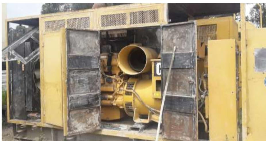
*Nota.* Remoción de cemento del motor y limpieza de sus terminales de entrada y salida de fluidos.
