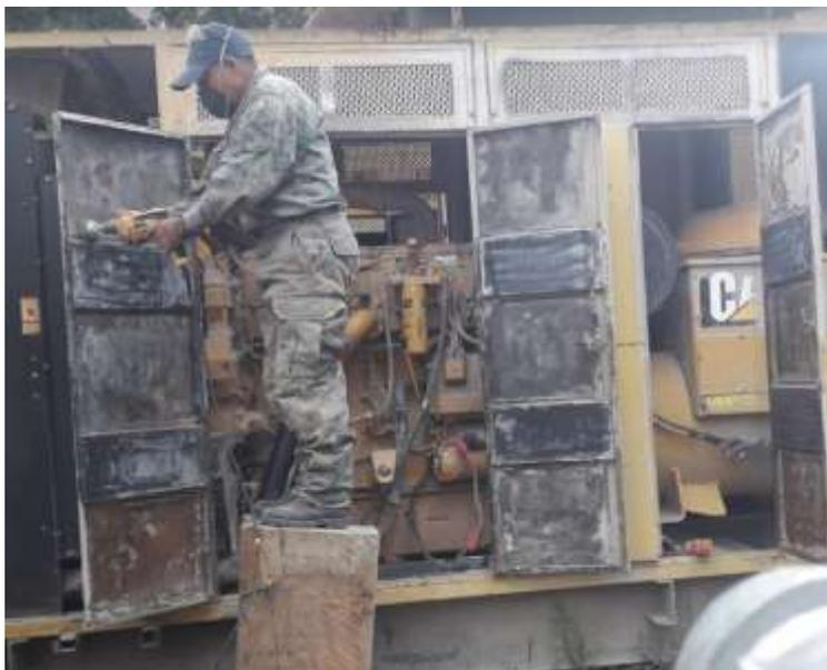
Nota. Parte externa del generador cubierta con cemento y daños por factor climático.
