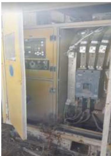
*Nota.* Tablero de control recubierto de cemento y material de construcción
