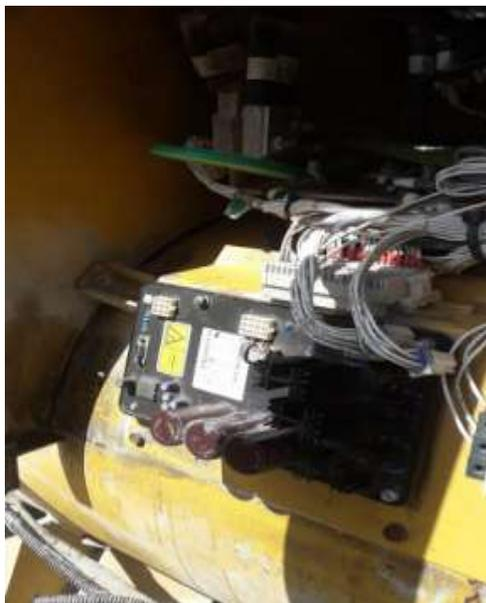
*Nota.* Módulo de control electrónico limpio después de remover capas de hormigón.
