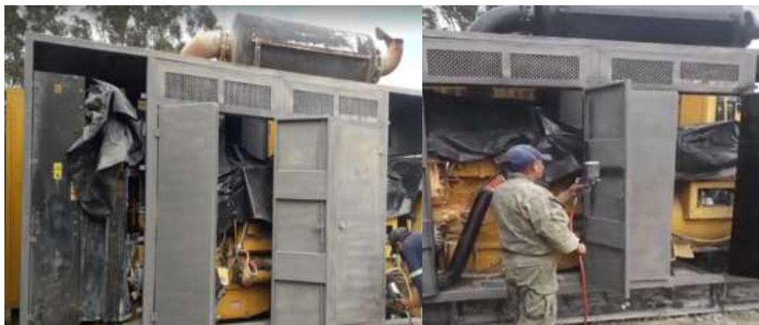
Nota. Pintura base en la parte externa del grupo electrógeno previo a pintar con el color definitivo amarillo Caterpillar.
