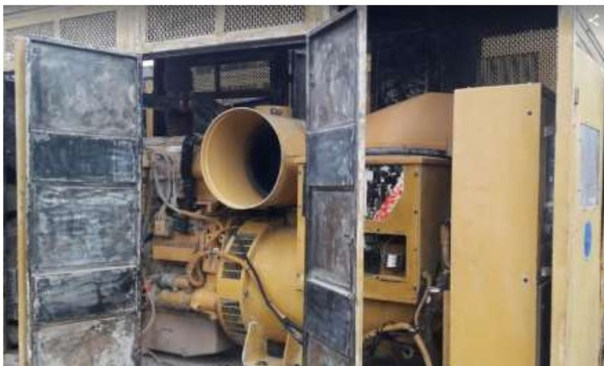
*Nota.* Parte interna del grupo electrógeno removido la capa de cemento y realización de limpieza de sus circuitos.
